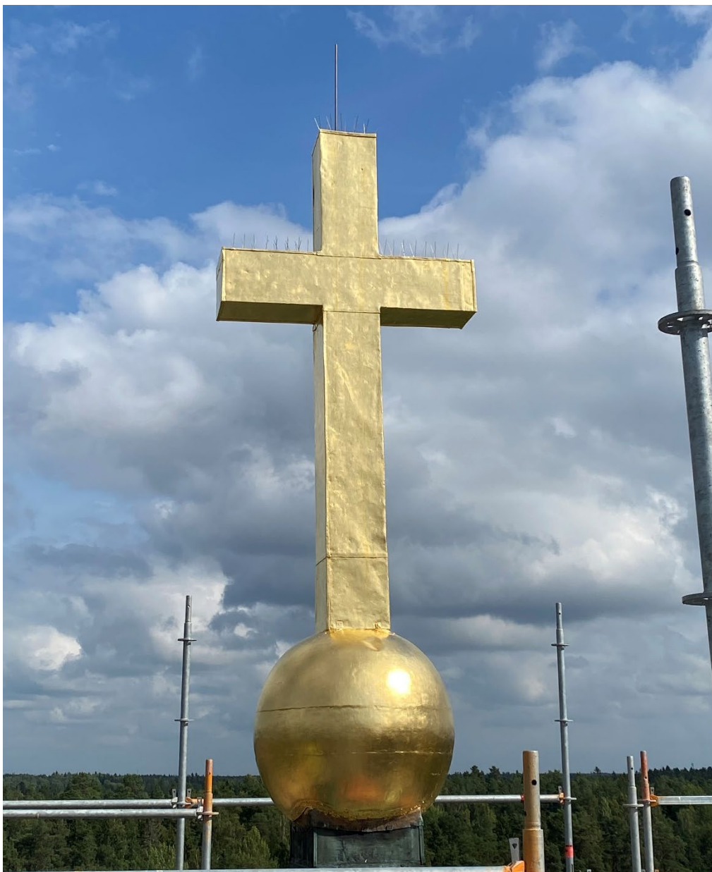
Figur 11. Tornkorset med underliggande klot har omförgyllts inom detta projekt. Nya fågelpiggas är monterade på korsarmarna och på korsets topp. Foto: Ulrika Olsson, 2024-08-21.
