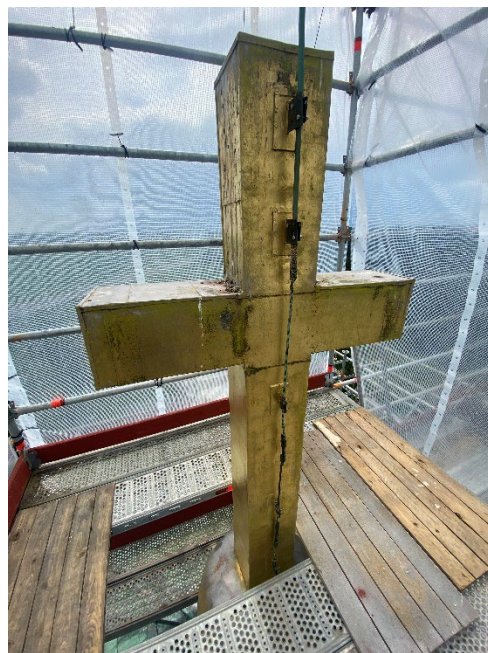
Figur 6 och figur 7. Ristningar i kopparplåten, förmodligen från omläggningen år 1923. Till höger tornkorset som var i behov av omförgyllning. Utefter korset är åskledaren monterad. Foto: Ulrika Olsson, 2024-06-03.
