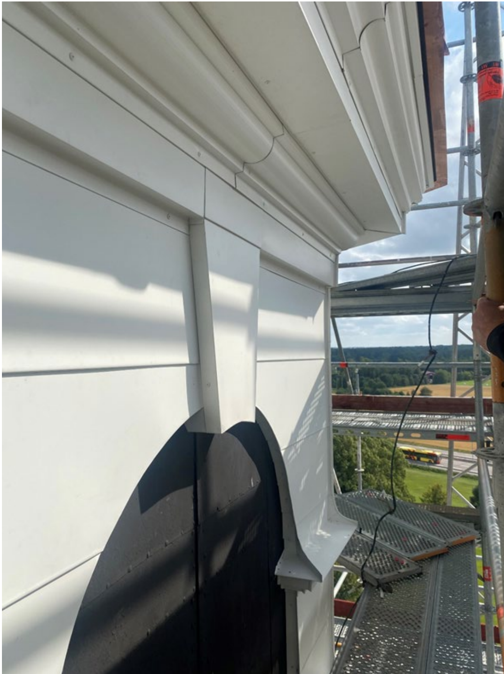
Figur 17. Lanterninens fasad har klätts med plåt, liksom dess båda profilerade lister, en på fasaden och en vid takfoten. Foto: Ulrika Olsson, 2024-08-21.
