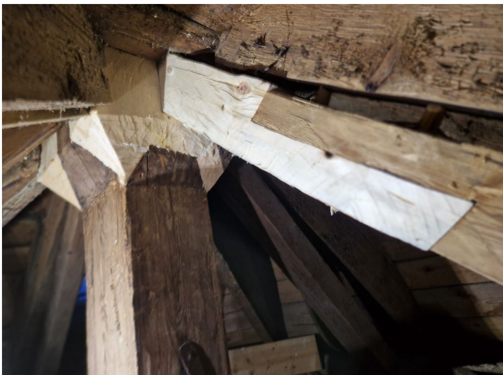
Figur 14. Timmerlagningar under lanterninhuvens topp. Foto: Daniel Åkerman, 2024-08-21.
