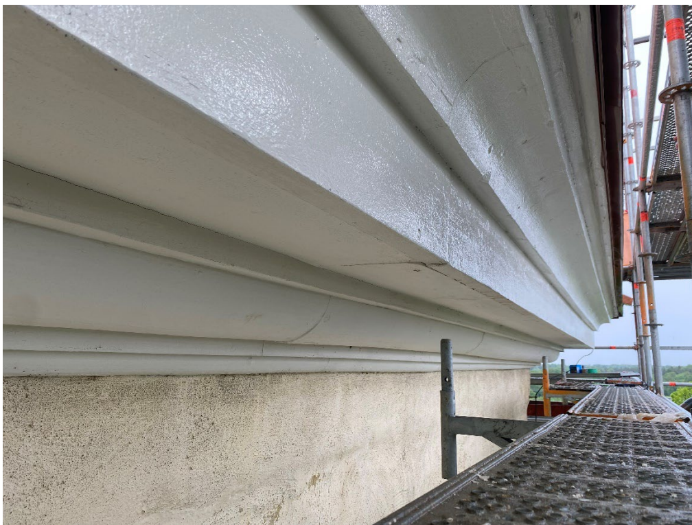
Figur 31. Den profilerade listen mellan tornets mur och tornbuven har renoverats. Foto: Ulrika Olsson, 2025-06-11.
