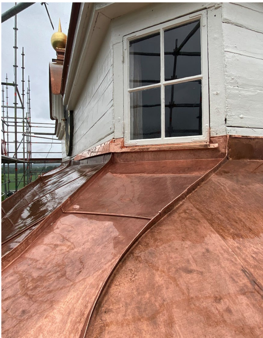
Figur 30. Nyrenoverad fönsterbåge samt ny plättäckning på tornhuvens taklist. Foto: Ulrika Olsson, 2025-06-11.
