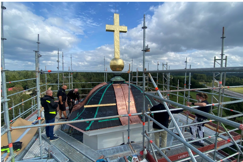
Figur 15. Under pågående arbeten med plåtläggning på lanterninbuven. Notera att plätinklädnaden kring tornkorsets fot har behållits. Foto: Ulrika Olsson, 2024-08-21.
