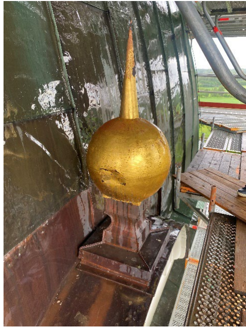
Figur 4 och figur 5. Plättäckningen på tornbuven innan påbörjade arbeten. En av klockornamenten innan påbörjade arbeten. Foto: Ulrika Olsson, 2024-06-03.
