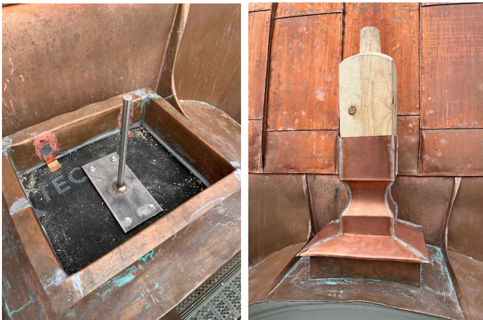
Figur 24 och figur 25. Under pågående arbeten med återmontering av ornamenten. Två av trästommarna har nytillverkats med de gamla stommarna som förlaga. Foto: Franzéns Plåt, sommaren 2025.
