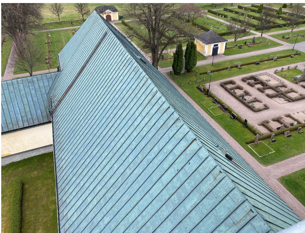
Figur 9. Långhusets tak sett från tornet innan påbörjade arbeten. Foto: Ulrika Olsson, 2025-04-24.
