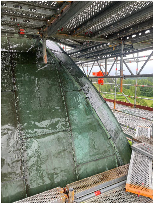
Figur 4 och figur 5. Plättäckningen på tornbuven innan påbörjade arbeten. En av klockornamenten innan påbörjade arbeten. Foto: Ulrika Olsson, 2024-06-03.
