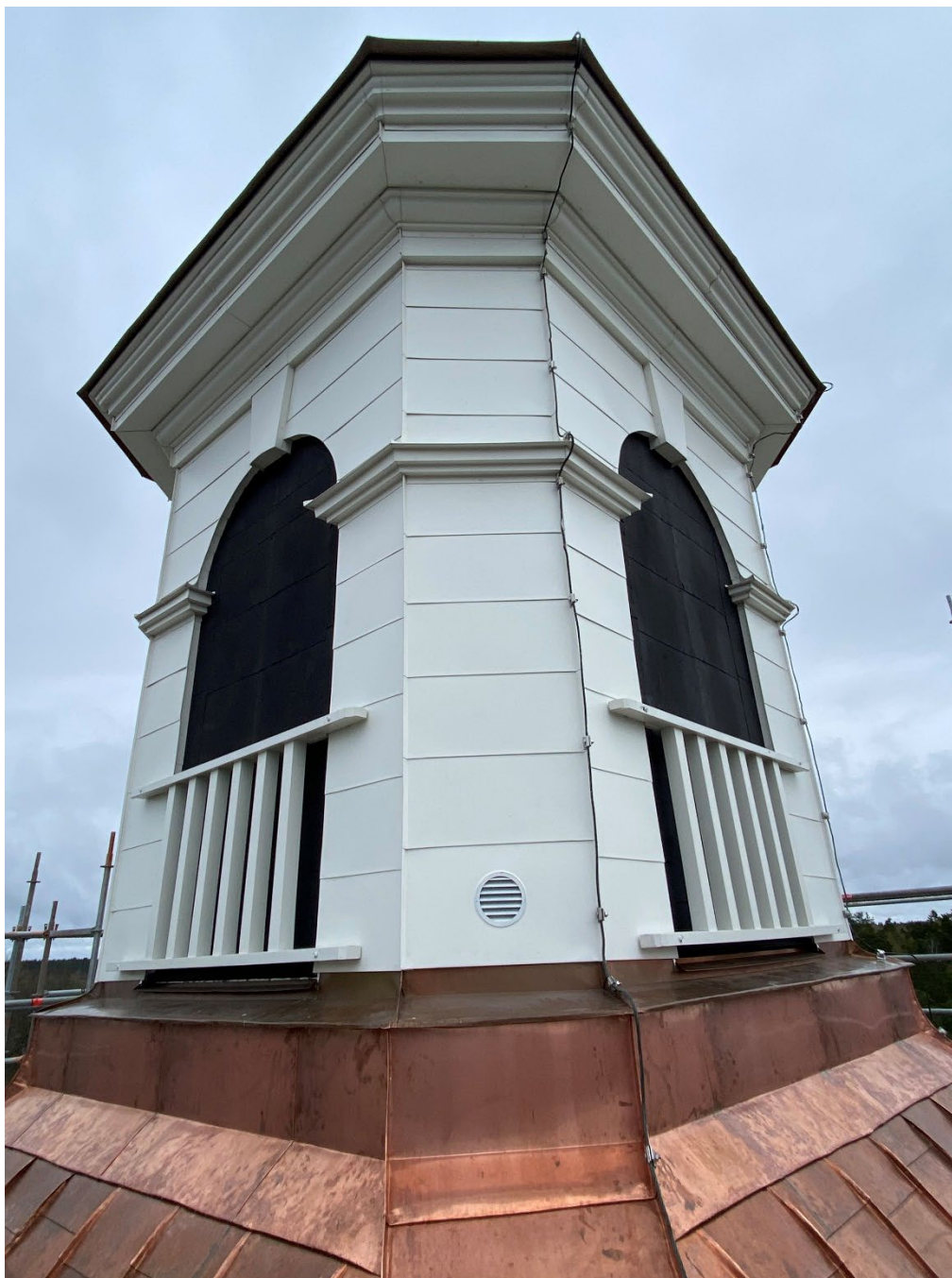
Figur 19. Lanterninens träpanel har klätts in i slättäckt plåt i ett utförande som ligger nära den tidigare träfasaden. Notera även de nyrenoverade träräckena och den nya utformningen på ventilationshålen i lanterninväggen. Luckorna är ännu inte ommålade. Foto: Ulrika Olsson, 2025-04-24.
