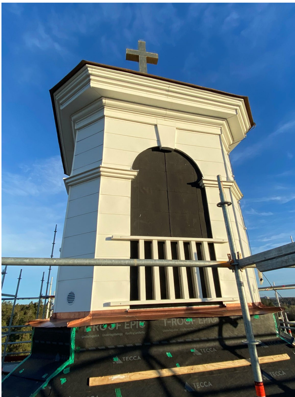
Figur 18. Lanterninens träpanel har klätts in i slättäckt plåt i ett utförande som ligger nära den tidigare träfasaden. Notera även de nyrenoverade skyddsräckena och den nya utformningen på ventilationsbålen i lanterninväggen. Luckorna är ännu inte ommålade. Foto: Ulrika Olsson, 2024-11-15.
