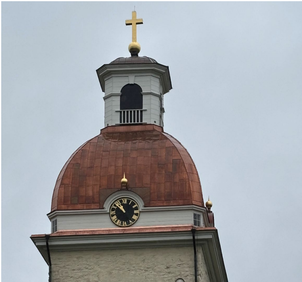
Figur 33. Tornet efter avslutade arbeten. Notera den på fasaden något indragna placeringen av utkastare och vattkypor. Foto: Ulrika Olsson, 2025-07-03.
