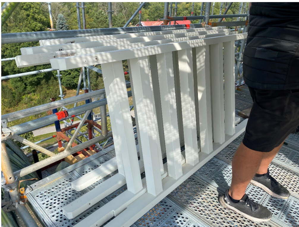
Figur 20. Skyddsräckena i trä har renoverats på ställningen. Här väntar de på att återmonteras framför lanterninluckorna. Foto: Ulrika Olsson, 2024-08-21.
