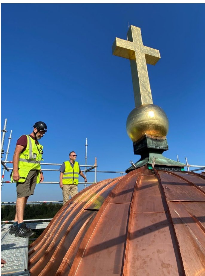
Figur 16. Vid slutbesiktningen av lanterninbuvens plåtläggning samt förgyllning av korset. Arbetena var inte färdigställda. Notera att tornkorsets plåt och lanterninbuvens plåt ännu inte är ihopfalsade. På fotot syns besiktningsman Mats Jonaeson och projektledaren Per-Erik Knapp. Foto: Ulrika Olsson, 2024-09-06.
