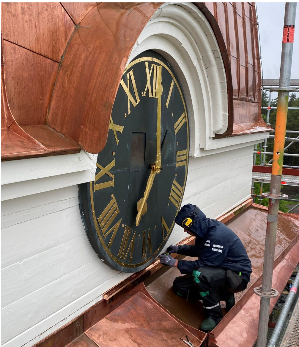
Figur 28. Siffror, punkter och visare har omförgyllts inne på verkstad. Foto: Ulrika Olsson, 2025-06-11.
