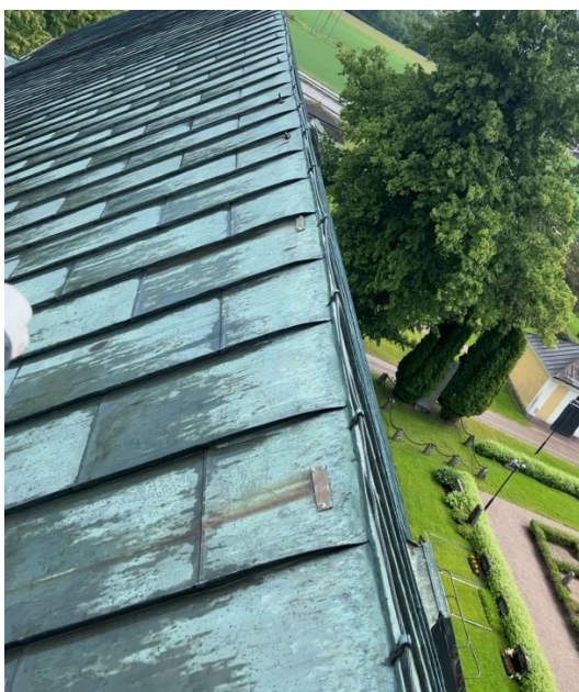
Figur 36. Mindre hål har lagats på långhusets tak med hjälp av plattjärn av koppar.
