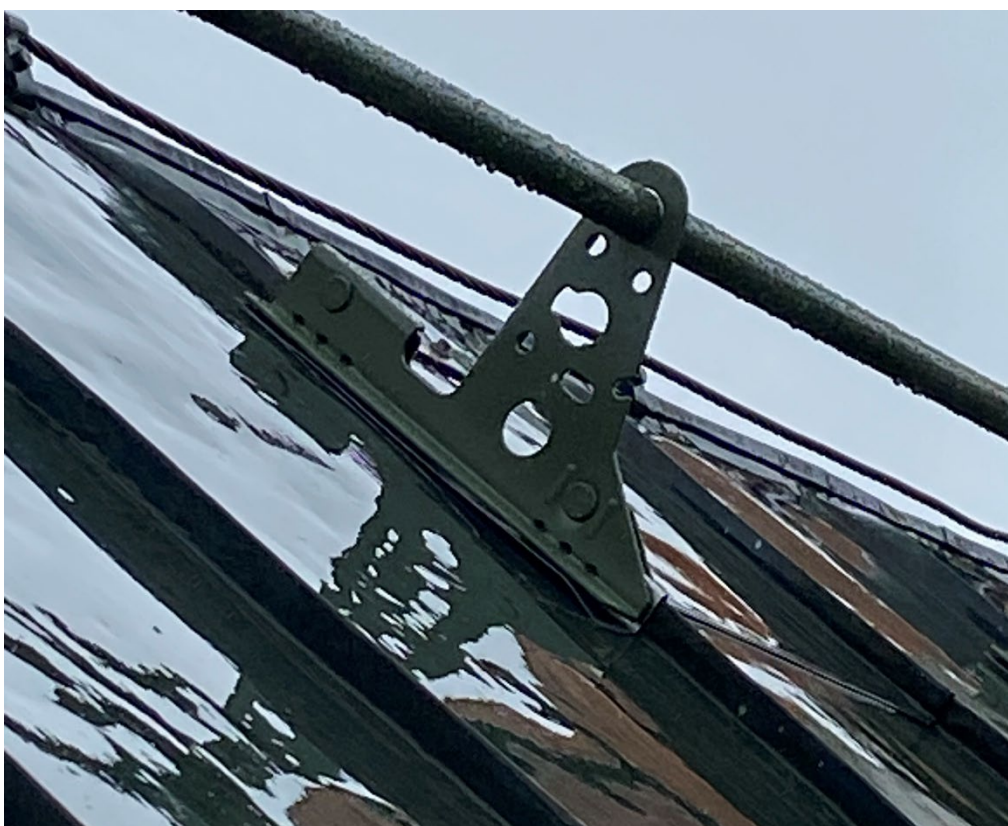
Figur 35. Nockrället är fäst i falserna. Foto: Ulrika Olsson, 2025-07-03.
