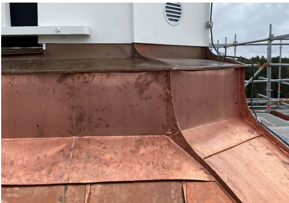
Figur 22. Lanterninens sockel efter avslutade arbeten. Foto: Ulrika Olsson, 2024-04-24.
