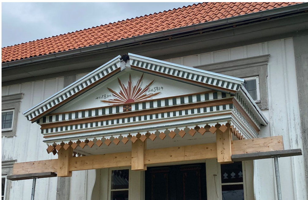
Figur 9. Gavelstycket pallades upp innan underliggande delar demonterades och till viss del sanerades. På fotot är målningsarbetet slutfört och det enda som återstår på gavelstycket är monteringen av kronan och återmonteringen av takeglet. Foto: Ulrika Olsson, 2025-09-02.
