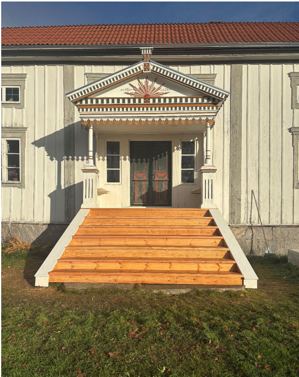
Figur 13. Den färdigrenoverade brokvisten på hälsingegården Skogens. Notera det lätt utställda trapploppet. Foto: Ulrika Olsson, 2025-10-29.
