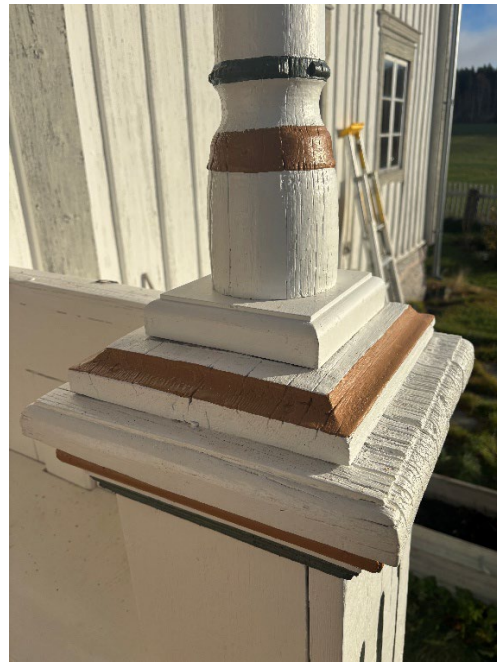
Figur 15 och figur 16. De översta brickorna under stolparna är nytillverkade. Foto: Ulrika Olsson, 2025-10-29.
