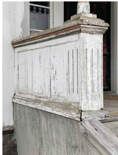
Figur 7 och figur 8. Innan påbörjade arbeten. Mellanrummet mellan socklar och stolpar utgjordes av tre brickor, varav den översta bedömdes som sentida av Martin Karlsson, Lassa's Byggnadsvård. Foto: Ulrika Olsson, 2025-02-21.
