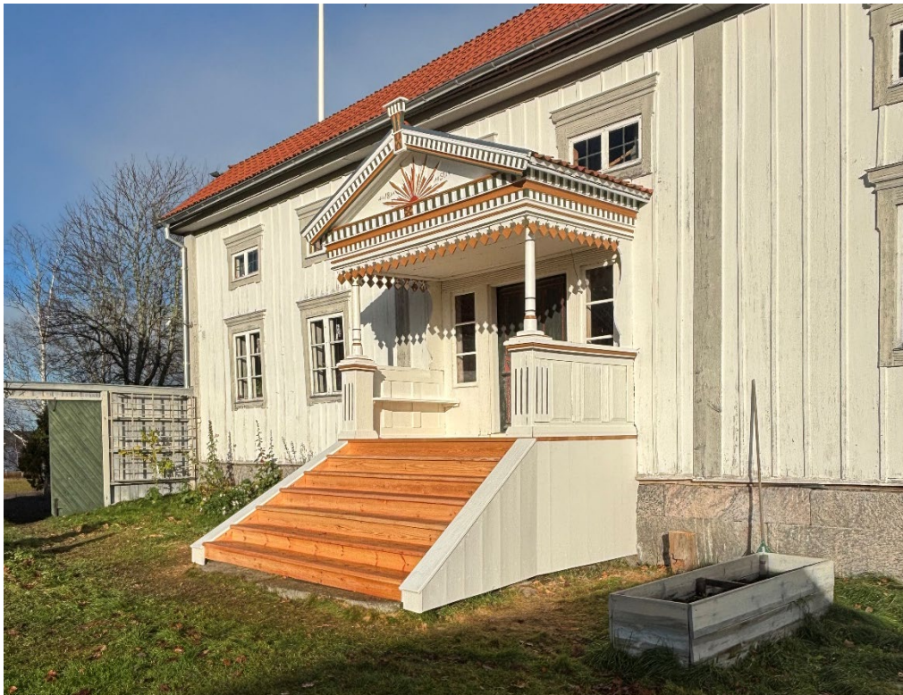
Figur 20. Den färdigrenoverade brokvisten på hälsinggården Skogens. Foto: Ulrika Olsson, 2025-10-29.
