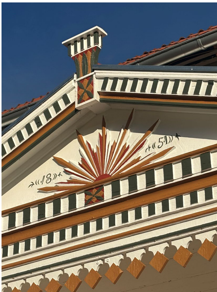
Figur 12. Närbild på det renoverade gavelstycket. Kronans översta topp är nytillverkad. Nytt virke sitter även i bakre halvan av kronans tjocklek. Foto: Ulrika Olsson, 2025-10-29.
