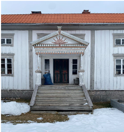
Figur 5 och figur 6. Innan påbörjade arbeten. Brokvistens trapplopp var nästintill rakt. På den östra sidan fanns en lucka som ledde in under brokvisten. Foto: Ulrika Olsson, 2025-02-21.
