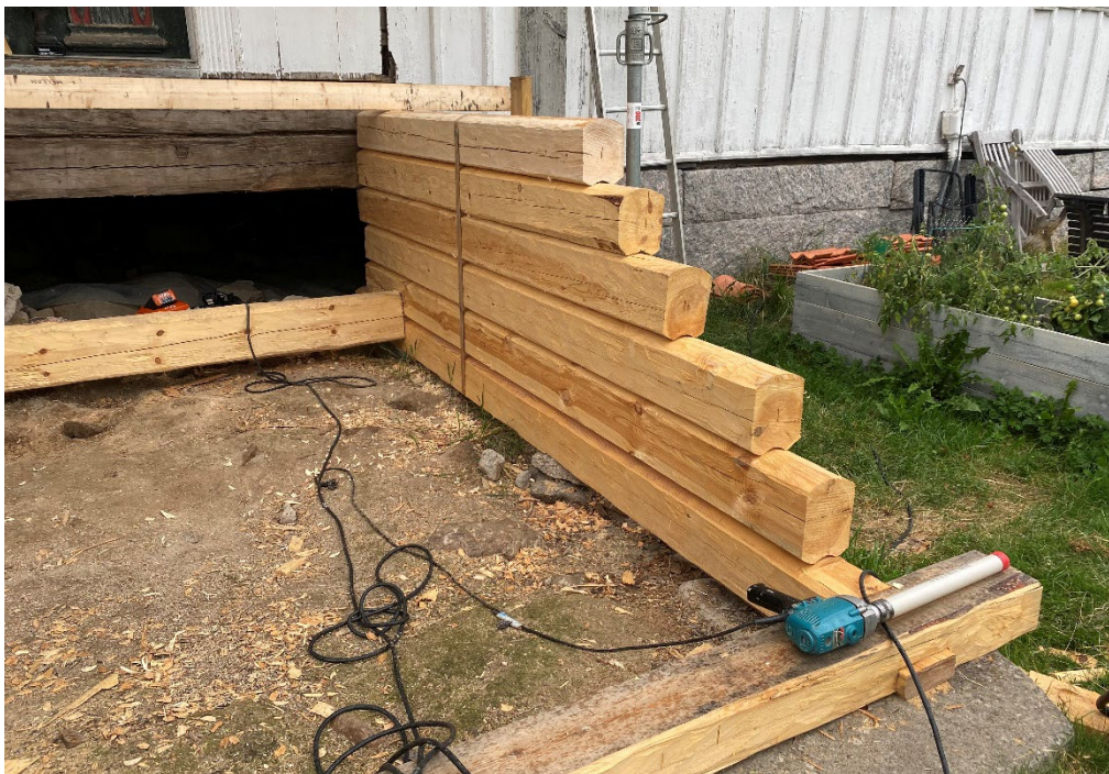
Figur 11. Här syns hur brokistans sidor är höjtimrade med en stock längst bak och en stock längst fram. Foto: Ulrika Olsson, 2025-09-02.
