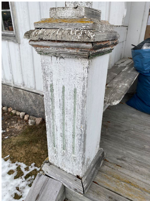
Figur 7 och figur 8. Innan påbörjade arbeten. Mellanrummet mellan socklar och stolpar utgjordes av tre brickor, varav den översta bedömdes som sentida av Martin Karlsson, Lassa's Byggnadsvård. Foto: Ulrika Olsson, 2025-02-21.
