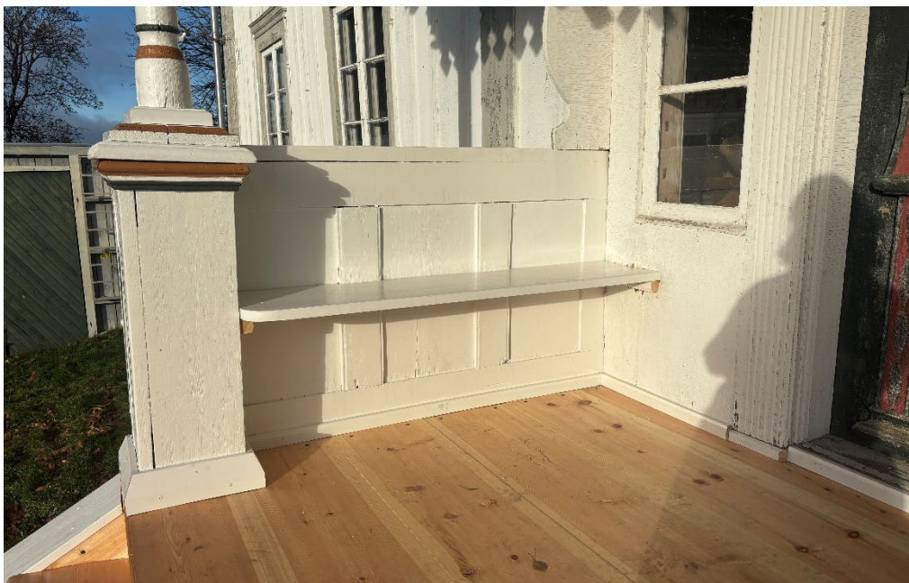
Figur 17. Nya lister har tillverkats kring socklarna liksom nya bänkskivor. Kompletteringsmålning kvarstod vid slutbesiktningen. Foto: Ulrika Olsson, 2025-10-29.
