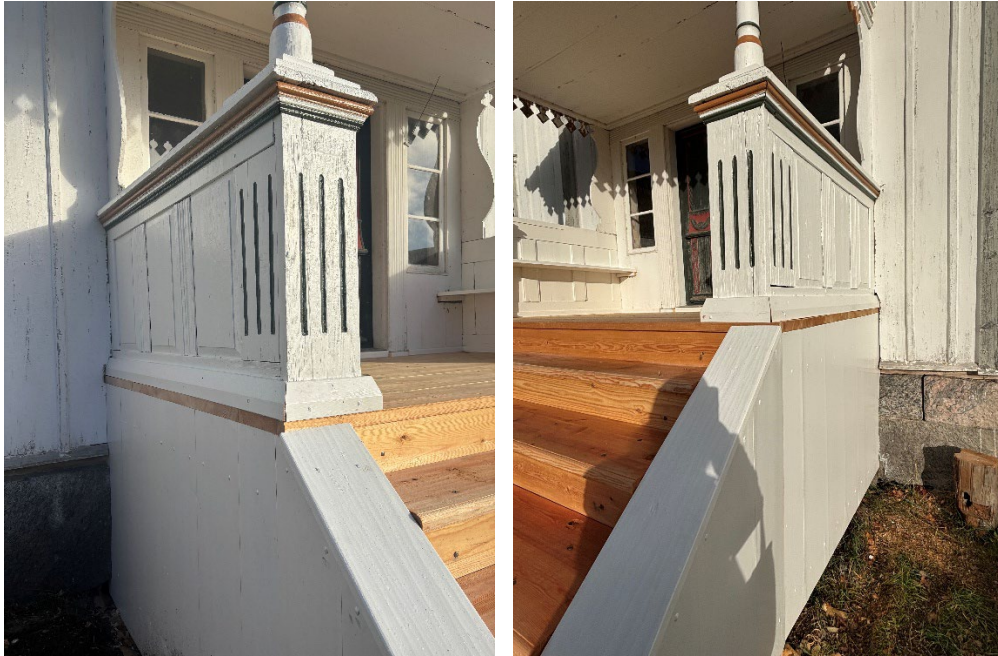
Figur 18 och figur 19. Panelen i sidorna, liksom trappans sidostycken är nytillverkade. Foto: Ulrika Olsson, 2026-10-29.
