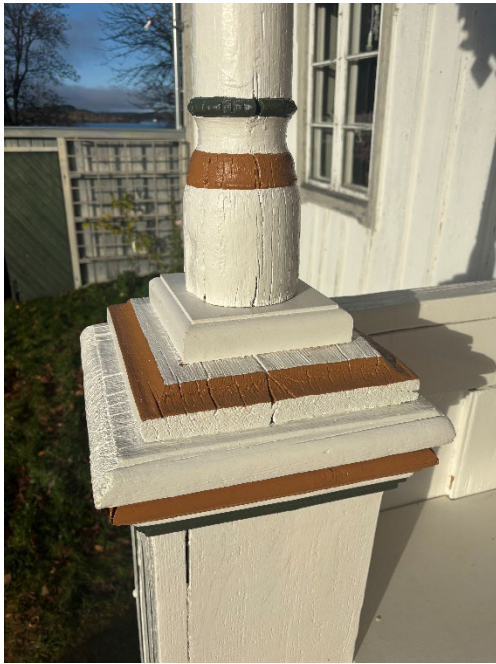
Figur 15 och figur 16. De översta brickorna under stolparna är nytillverkade. Foto: Ulrika Olsson, 2025-10-29.
