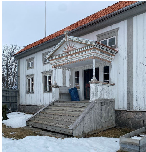
Figur 5 och figur 6. Innan påbörjade arbeten. Brokvistens trapplopp var nästintill rakt. På den östra sidan fanns en lucka som ledde in under brokvisten. Foto: Ulrika Olsson, 2025-02-21.
