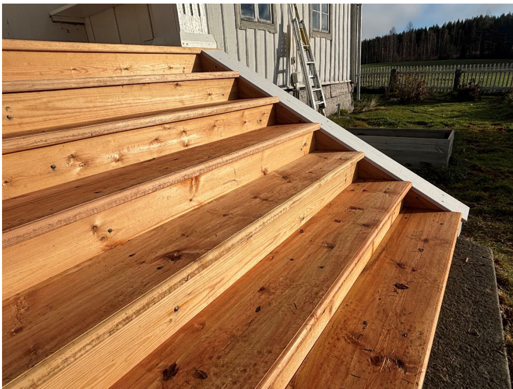
Figur 14. Stegens och broplanets ytskikt är hyvlade med oxhyvel som ger en levande yta. Foto: Ulrika Olsson, 2025-10-29.
