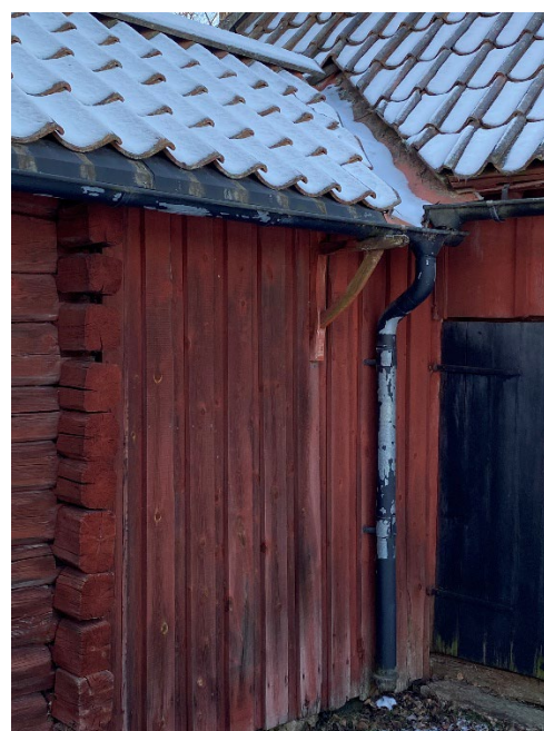
Figur 6 och figur 7. Innan påbörjade arbeten. Takpannorna på arkivdelen var nertill iskarvade med en missprydande takfotsplåt. Foto: Ulrika Olsson, 2025-02-20.
