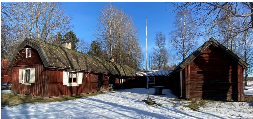
Figur 3. Lunds gammelgård innan påbörjade arbeten. Gården sett från väster. Foto: Ulrika Olsson, 2025-02-20.
