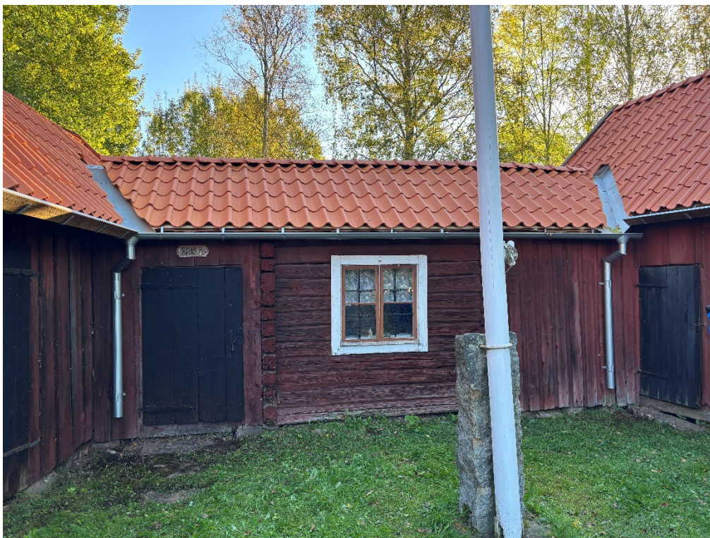
Figur 13. Efter avslutade arbeten. takfallen på arkivdelen har belagts med fyra och en halv rader takpannor. Tidigare utförande var med fyra rader takpannor medan resterande takfall täcktes med en misspnydande takfotsplåt längst ner. På fotot syns också de nytillverkade ränndalarna, hänggränna och stuprören med skarpa vinklar.
