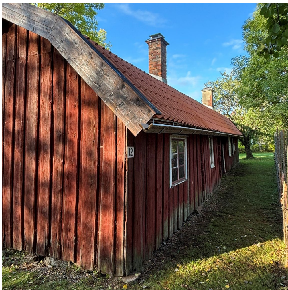
Figur 12. Efter avslutade arbeten. Bostadsdelen sedd från nordöst. Även här har nya hängrännor i trä monterats. Notera skorstenarnas nya beslag. Foto: Ulrika Olsson, 2025-09-29.
