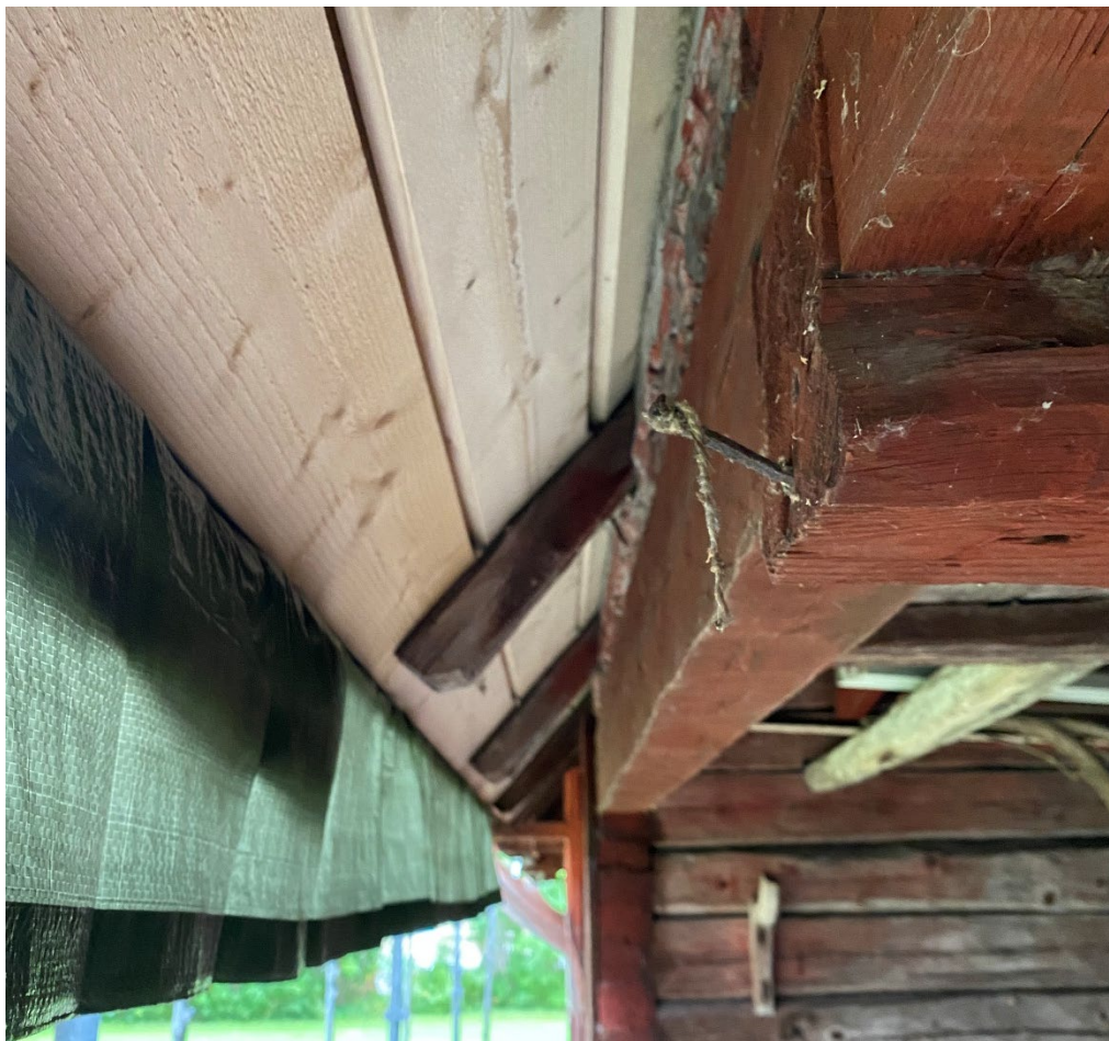
Figur 10. Under pågående arbeten. Ny takpanel är synlig vid den öppna delen mellan bostadsdel och brysstuga/galleri. Foto: Ulrika Olsson, 2025-09-02.
