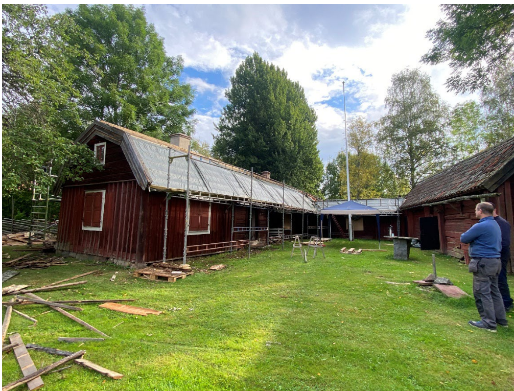
Figur 8. Under pågående arbeten. Vid besöket pågick arbetena på bostadsdelens brutna tak. Foto: Ulrika Olsson, 2025-09-02.
