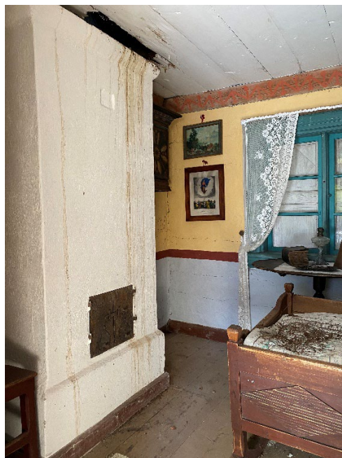
Figur 4 och figur 5. Innan påbörjade arbeten. Takläckaget som upptäcktes under sommaren 2024 var i anslutning till skorstenen i bostadsdelen. Ovanför rörspisen i kammaren syns hur läckaget har letat sig ner över spisen. Foto: Ulrika Olsson, 2025-02-20.
