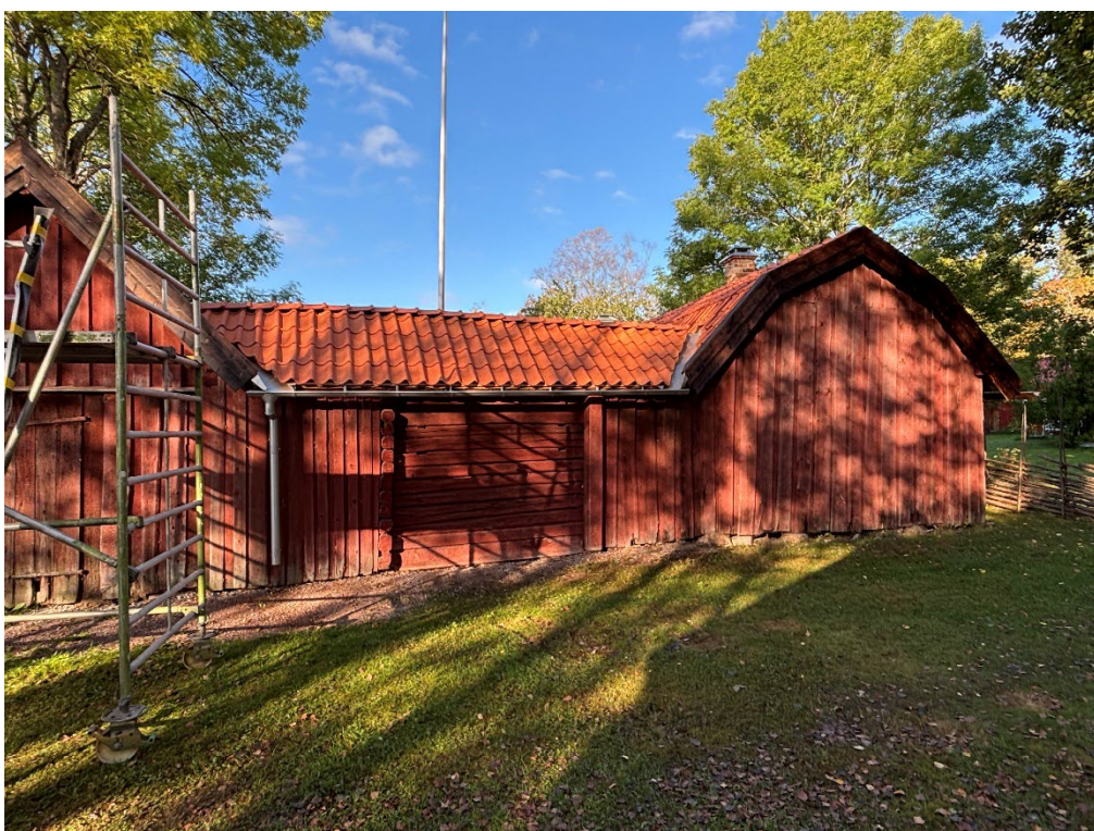
Figur 14. Efter avslutade arbeten. Vid slutbesiktningen pågick montering av stuprör på arkivdelens östra sida. Foto: Ulrika Olsson, 2026-09-29.
