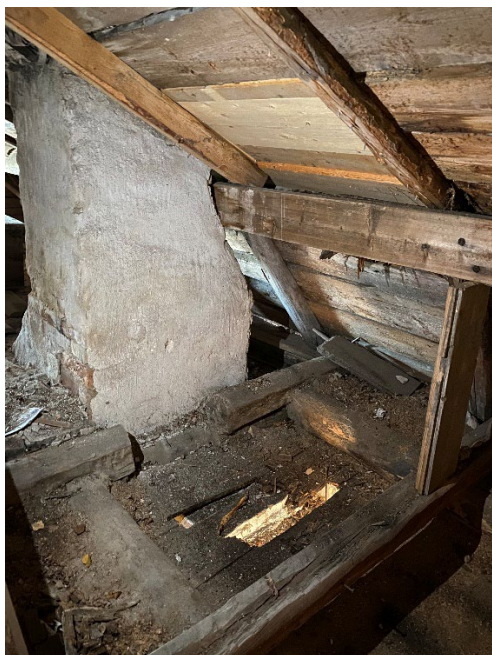
Figur 4 och figur 5. Innan påbörjade arbeten. Takläckaget som upptäcktes under sommaren 2024 var i anslutning till skorstenen i bostadsdelen. Ovanför rörspisen i kammaren syns hur läckaget har letat sig ner över spisen. Foto: Ulrika Olsson, 2025-02-20.
