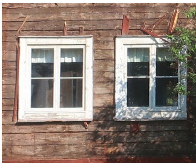
Figur 17. Fönster mot söder innan renovering. Foto från söder: Daniel Olsson, 2023-09-11.
