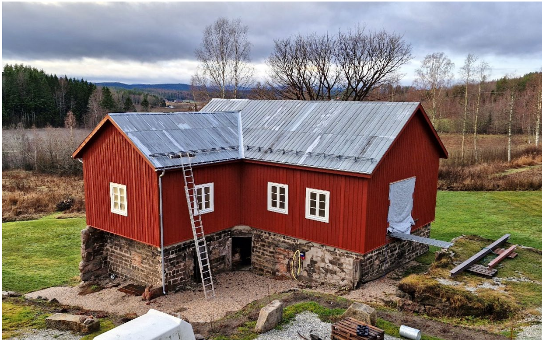
Figur 44. Den nya ekonomibyggnaden uppförd på de bevarade slaggstensmurarna efter ladugårdens del från 1885. Foto från nordöst: Daniel Olsson, 2025-12-16.
