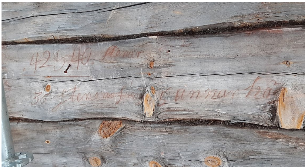
Figur 42. Inskription med rödkrita på bröllopsstugans timmerstomme på den västra fasaden nära den sydvästra knuten. Foto från sydväst: Daniel Olsson, 2025-01-28.
