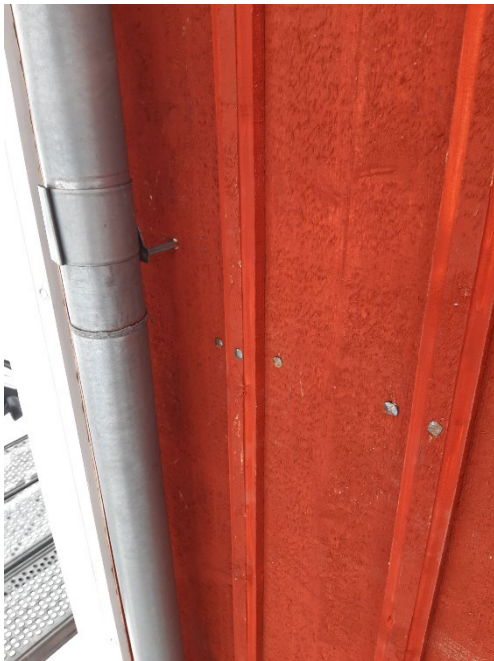
Figur 26. Detalj av panelen och det återuppsatta stupröret. Foto från sydöst: Daniel Olsson, 2025-01-28.
