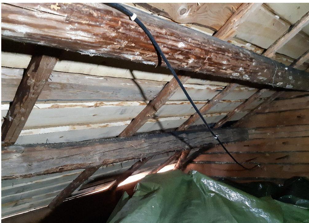
Figur 23. Detalj av det södra takfallet sett från vinden med ny taktro. Foto från nordöst: Daniel Olsson, 2023-11-07.
