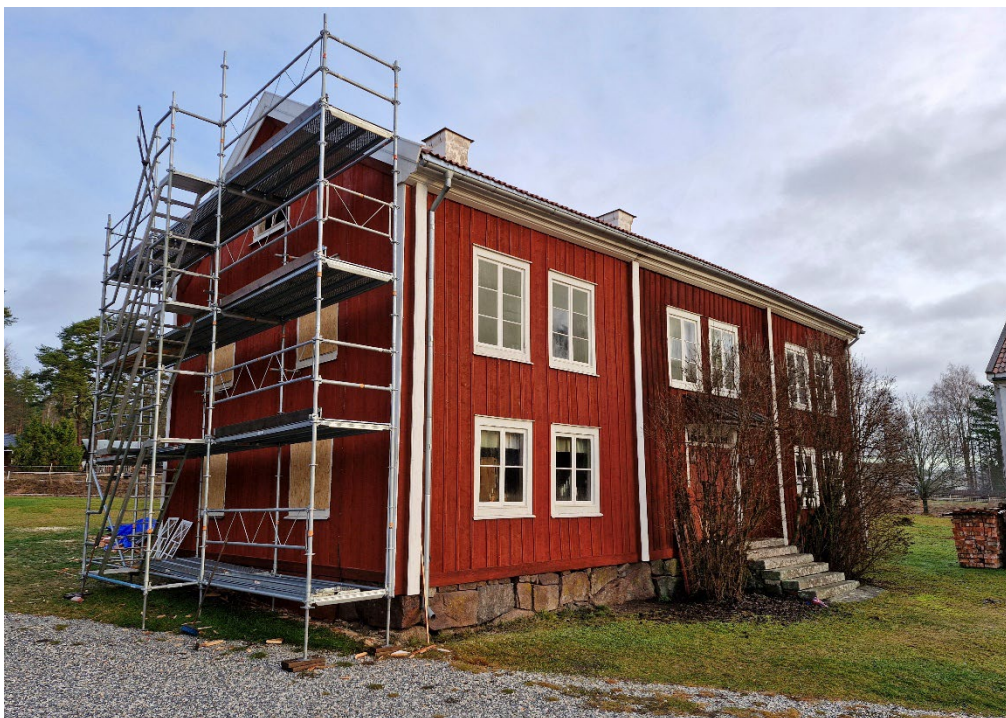
Figur 30. Bröllopsstugan från sydväst med ställning uppsatt vid husets västra gavel. Foto: Daniel Olsson, 2025-12-16.
