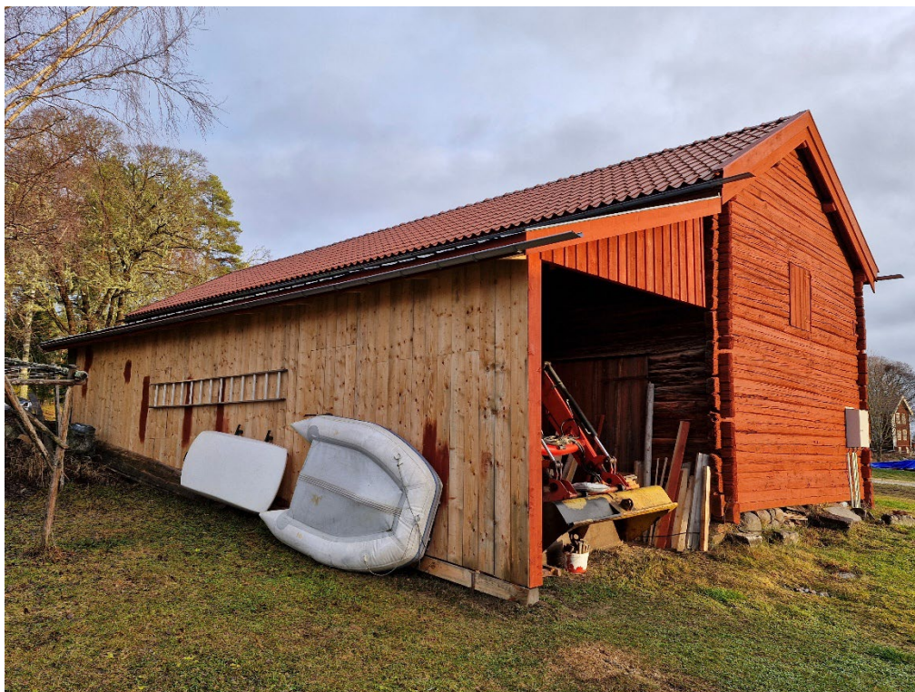
Figur 46. Den nyuppförda carporten från sydväst. Foto: Daniel Olsson, 2025-12-16.
