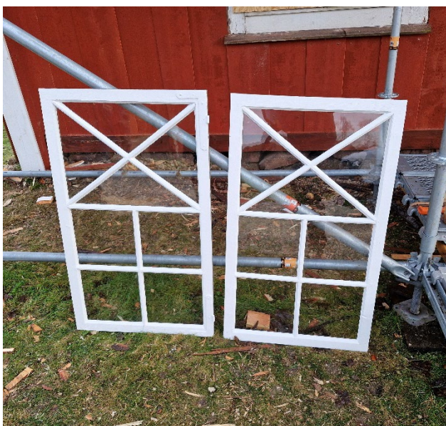
Figur 35. Renoverade fönsterbågar till vindsvåningens fönster mot väster. Foto: Daniel Olsson, 2025-12-16.
