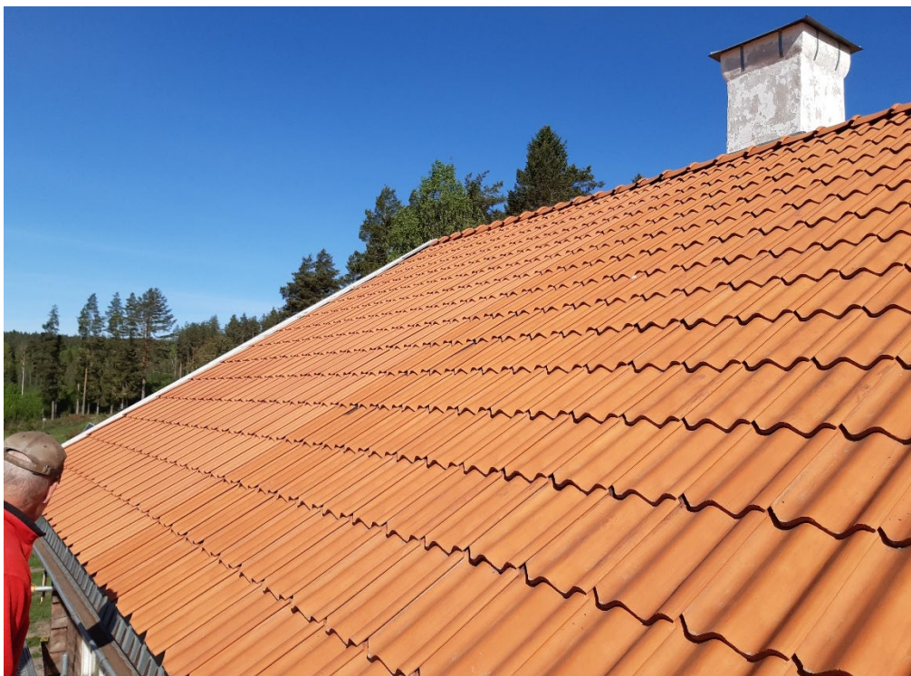
Figur 22. Det södra takfallet från sydöst efter omläggning. Foto: Daniel Olsson, 2023-11-07.
