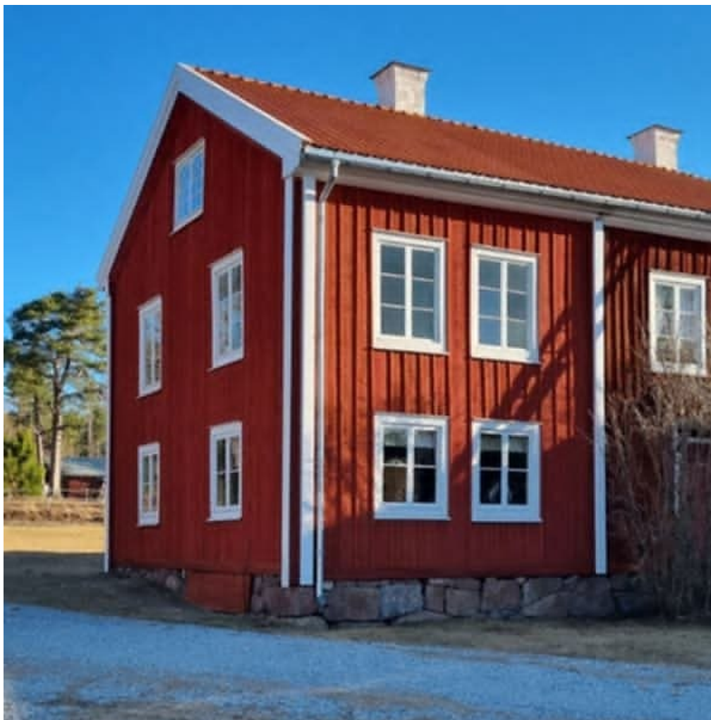
Figur 40. Bröllopsstugans västra del från sydväst efter avslutad renovering. Foto: Thomas Hägg, 2026-03-27.
