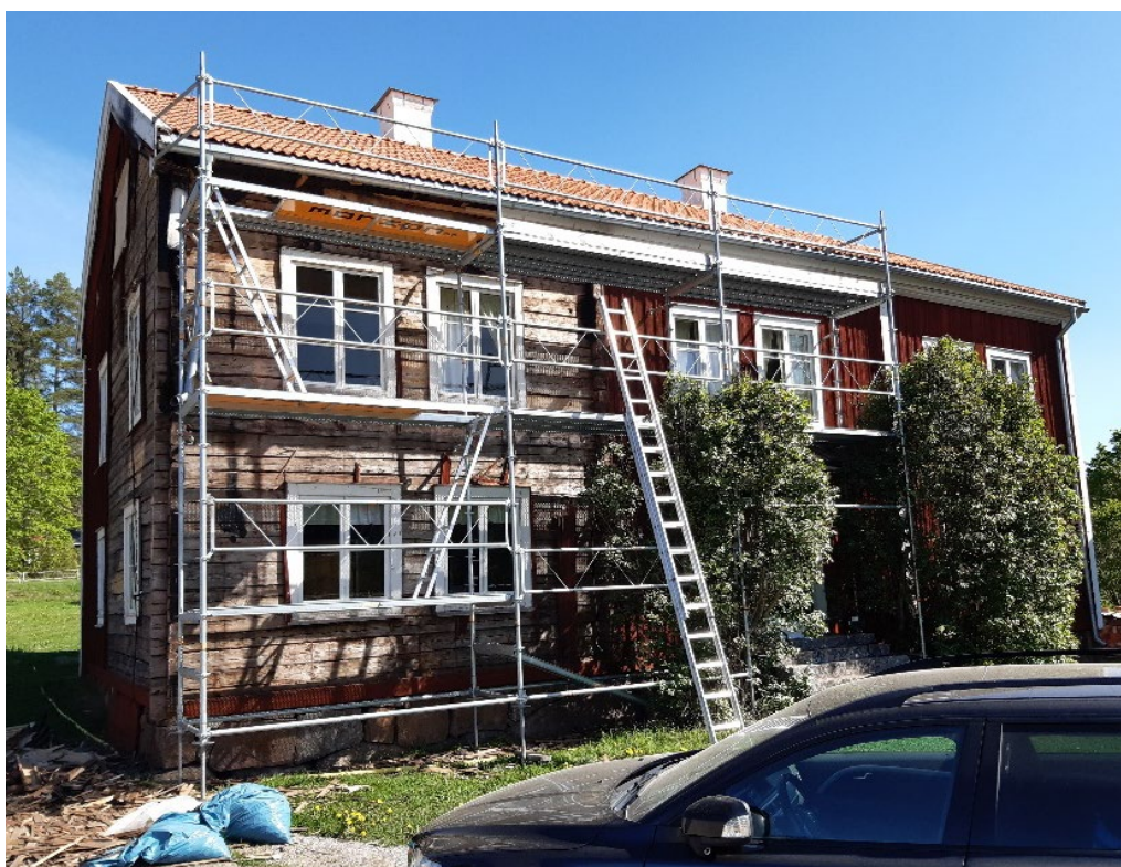
Figur 21. Ställning uppsatt vid den södra fasaden under arbetets tredje etapp. Foto från sydväst: Daniel Olsson, 2024-05-20.
