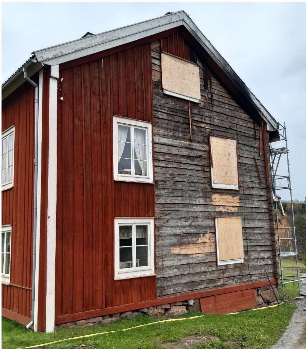
Figur 16. Bröllopsstugans västra fasad. Foto från väster: Daniel Olsson, 2024-05-20.
