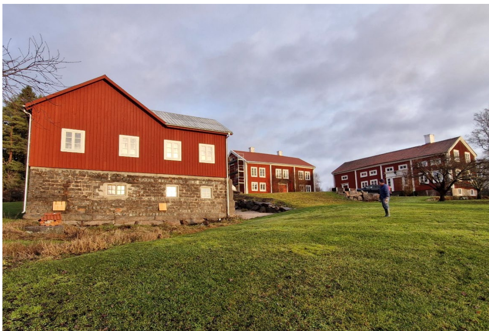
Figur 47. Gården från sydväst, från vänster i bild, den nybyggda ekonomibyggnaden, den restaurerade bröllopsstugan och boningshuset. Fastighetsägaren Thomas Hägg ses till höger i bild. Foto: Daniel Olsson, 2025-12-16.
