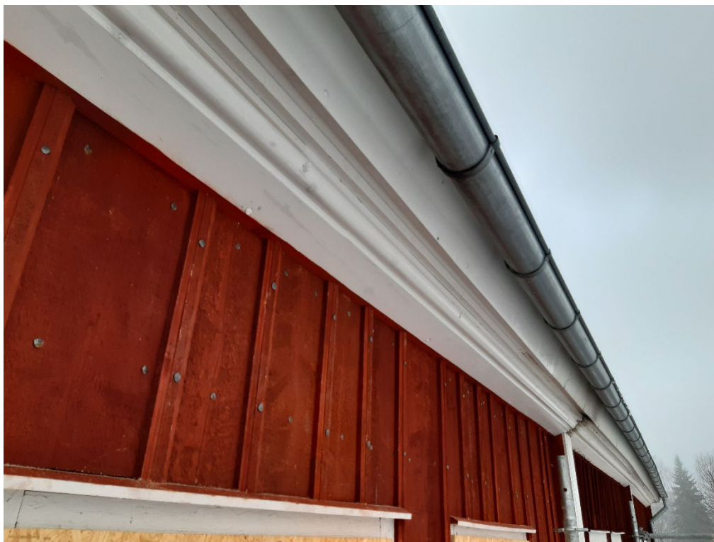
Figur 24. Detalj av locklistpanelen och den profilerade takfoten på den västra delen av husets södra fasad. Foto från sydväst: Daniel Olsson, 2025-01-28.
