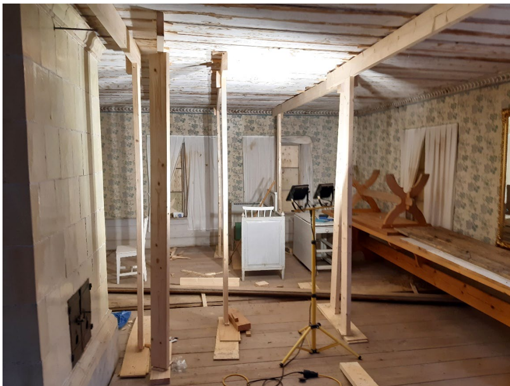
Figur 18. Den övre salen från norr med uppstämplat innertak. Foto: Daniel Olsson, 2023-10-26.
