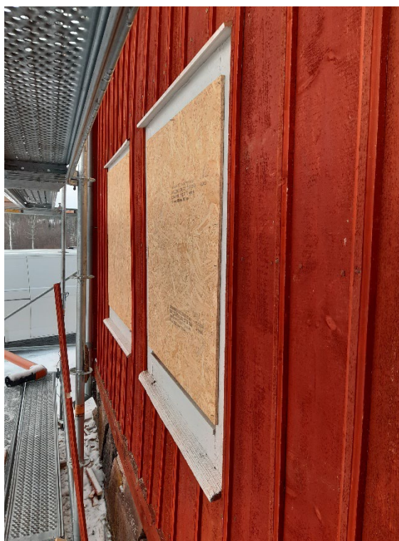
Figur 25. Detalj av panelen på den södra fasaden. Foto från sydöst: Daniel Olsson, 2025-01-28.
