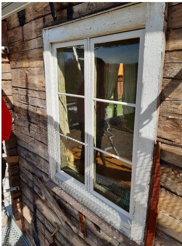
Figur 34. Detalj av renoverat fönster mot söder. Foto från sydöst: Daniel Olsson, 2024-05-20.
