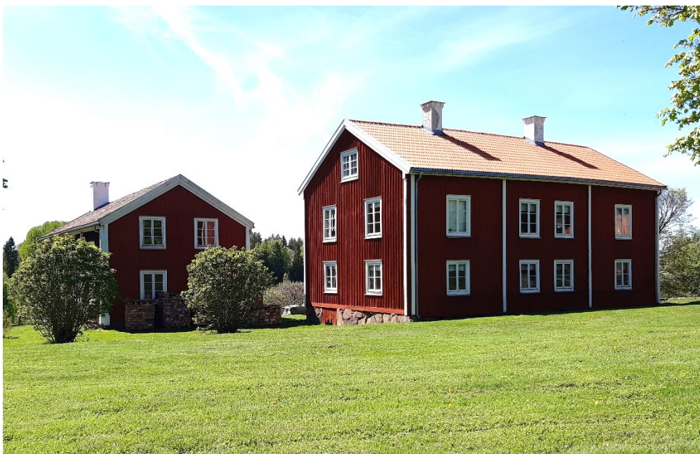
Figur 6. Boningshuset och bröllopsstugan från nordväst. Foto: Daniel Olsson, 2024-05-20.
