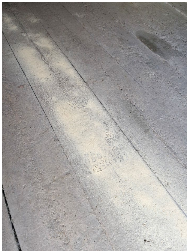
Figur 23. Interiör med mycket spår av trägnagare (träjöl) på golvet. Angreppet är sannolikt i golvplankorna i detta fall. Foto: Daniel Olsson, 2025-11-11.
