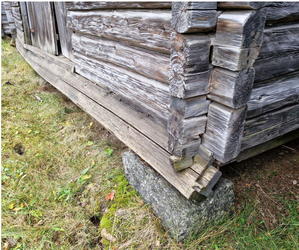
Figur 17. Detalj av syllstock som har pressats ut och vridit sig. Foto: Daniel Olsson, 2025-11-11.
