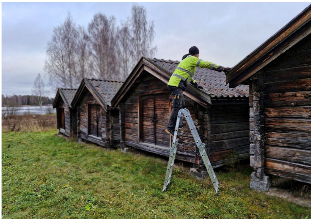
Figur 10. Martin Karlsson undersöker tegeltak under skadeinventeringen av kyrkstallarna i Stene, Järvsö. Foto från sydväst: Daniel Olsson, 2025-11-11.
