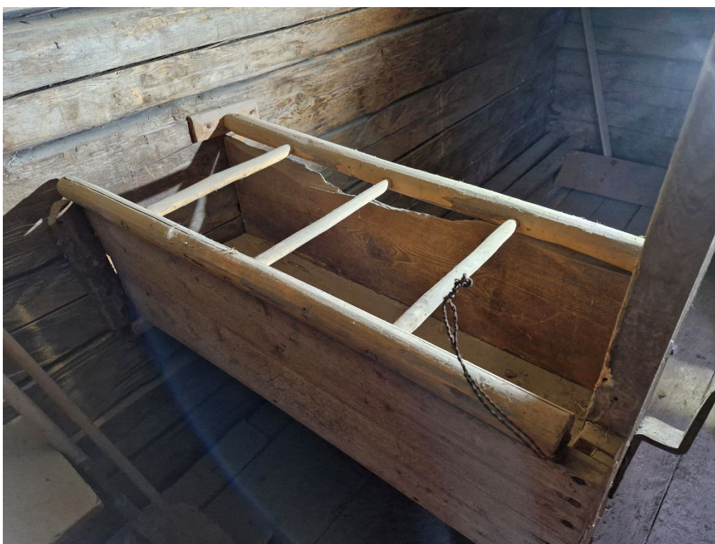
Figur 32. Detalj av krubba med tvärlå överst för att hålla höet på plats i krubban. Till höger ett vinklat järn för uppläggning av träbom. Foto: Daniel Olsson, 2025-11-11.
