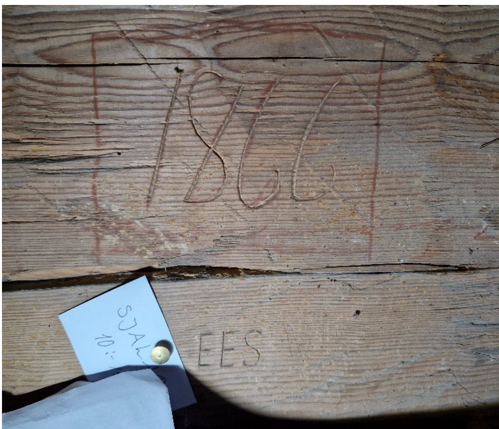
Figur 34. Detalj av inristning på väggen i stall nummer 20 med årtalet 1866 och initialerna EES. Foto: Daniel Olsson, 2025-11-04.
