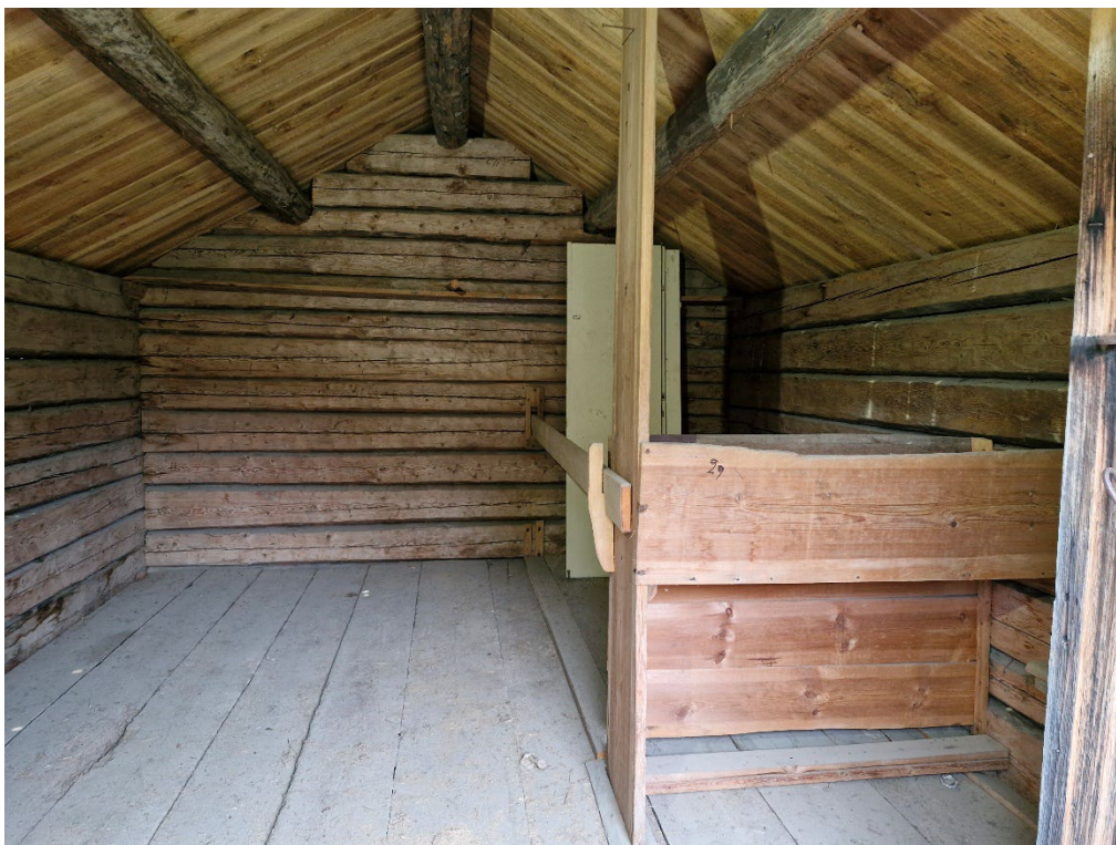
Figur 31. Kyrkstall med krubba med inre vertikal bräda och bom. Foto: Daniel Olsson, 2025-11-11.
