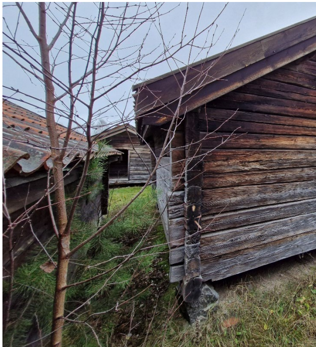
Figur 12. Träd som växer intill ett par kyrkstallar och som snart leder till skador på fasad och tak om det får stå kvar. Foto: Daniel Olsson, 2025-11-11.
