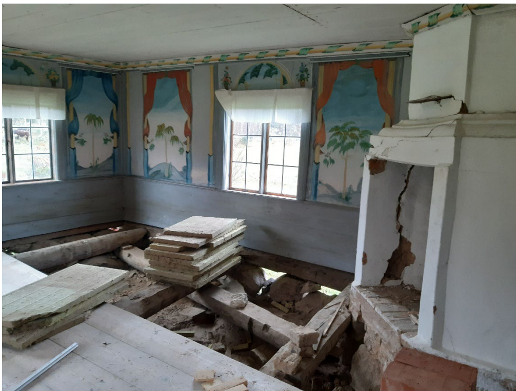
Figur 25. Golvet i herrstugan är upptaget och den öppna spisens grundläggning är synlig. Markisoleringen är upplagd i travar. Foto från öster: Daniel Olsson, 2024-10-31.
