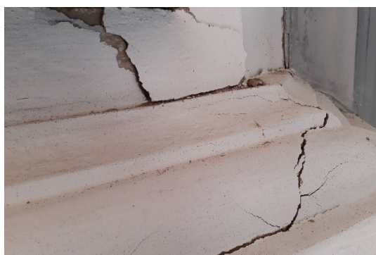
Figur 17. Detalj av sprickor på den öppna spisens bögra del. Foto från söder: Daniel Olsson, 2024-10-29.
