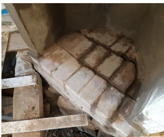
Figur 28. Den öppna spisens nederdel efter ommurning. Foto från sydöst: Daniel Olsson, 2024-11-27.
