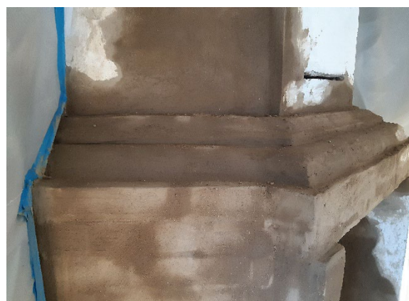
Figur 29. Detalj av den öppna spisens överdel från sydväst efter rekonstruktion av spiskåpens profiler. Foto: Daniel Olsson, 2024-11-27.
