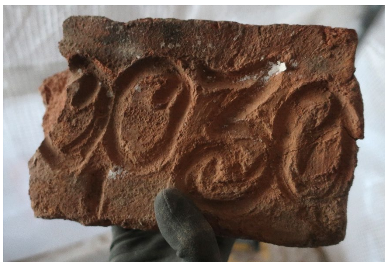
Figur 42. Tegelsten med märkning som påträffades inmurad i mellanstugans öppna spis. Foto: Daniel Olsson, 2024-11-27.
