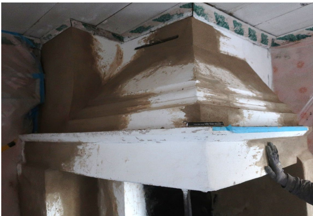
Figur 36. Detalj av den öppna spisens kåpa under restaureringen. Foto från öster: Daniel Olsson, 2024-12-19.
