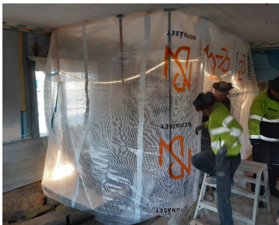
Figur 27. Skärmväggen av plast som sattes upp vid den öppna spisen. Foto från söder: Daniel Olsson, 2024-11-27.
