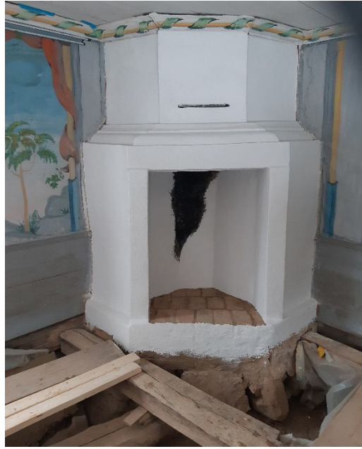
Figur 31. Den öppna spisen i herrstugan från söder efter avfärgning med limfärg, men innan golvet lades tillbaka. Foto: Daniel Olsson, 2024-11-27.
