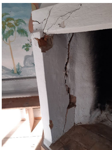
Figur 17. Detalj av sprickor på den öppna spisens bögra del. Foto från söder: Daniel Olsson, 2024-10-29.
