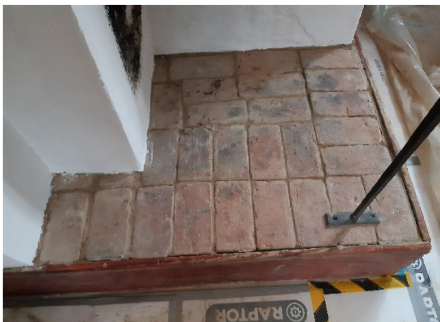
Figur 37. Detalj av den öppna spisens eldbärd efter omfogning. Foto från sydöst: Daniel Olsson, 2024-12-19.
