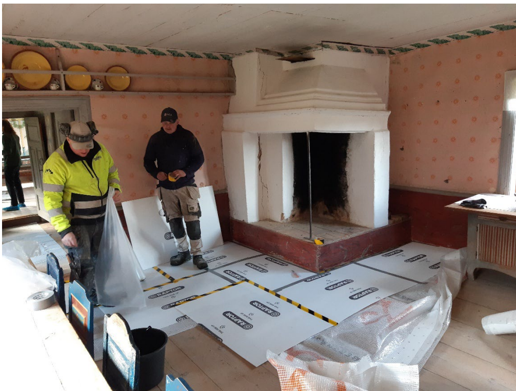
Figur 22. Täckning av golvet med papp innan arbetet inleddes. Foto från öster: Daniel Olsson, 2024-10-29.
