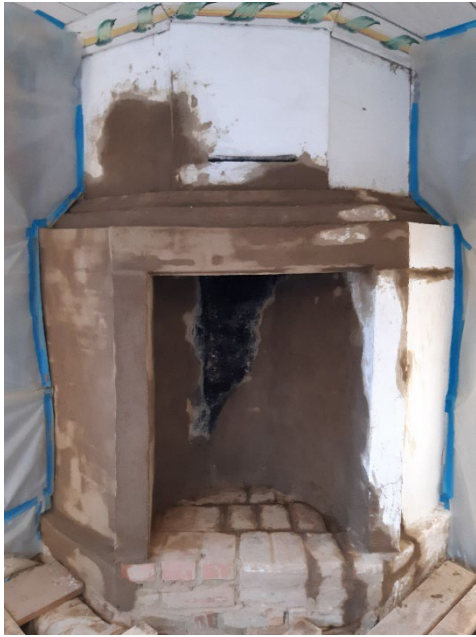
Figur 30. Den öppna spisen i herrstugan från söder efter avklarad putsning men innan avfärgning med limfärg. Foto: Daniel Olsson, 2024-11-27.
