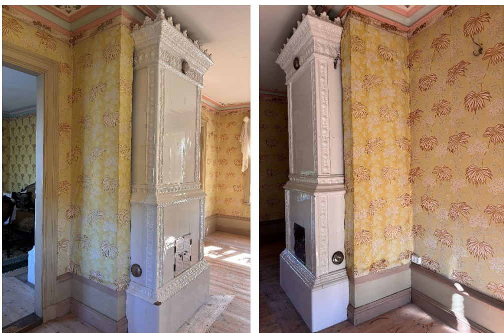
Figur 9 och 10. Murarna på sidorna av kakelugnen efter att tapeten renoverats. Dragningar har skurits upp och varsamt sträckts ut och limmats tillbaka. Löst hängande tapet har limmats tillbaka mot underlaget. Retuscheringar har gjorts vid vissa lagningar. Foto: Ulrika Olsson, 2026-08-28.
