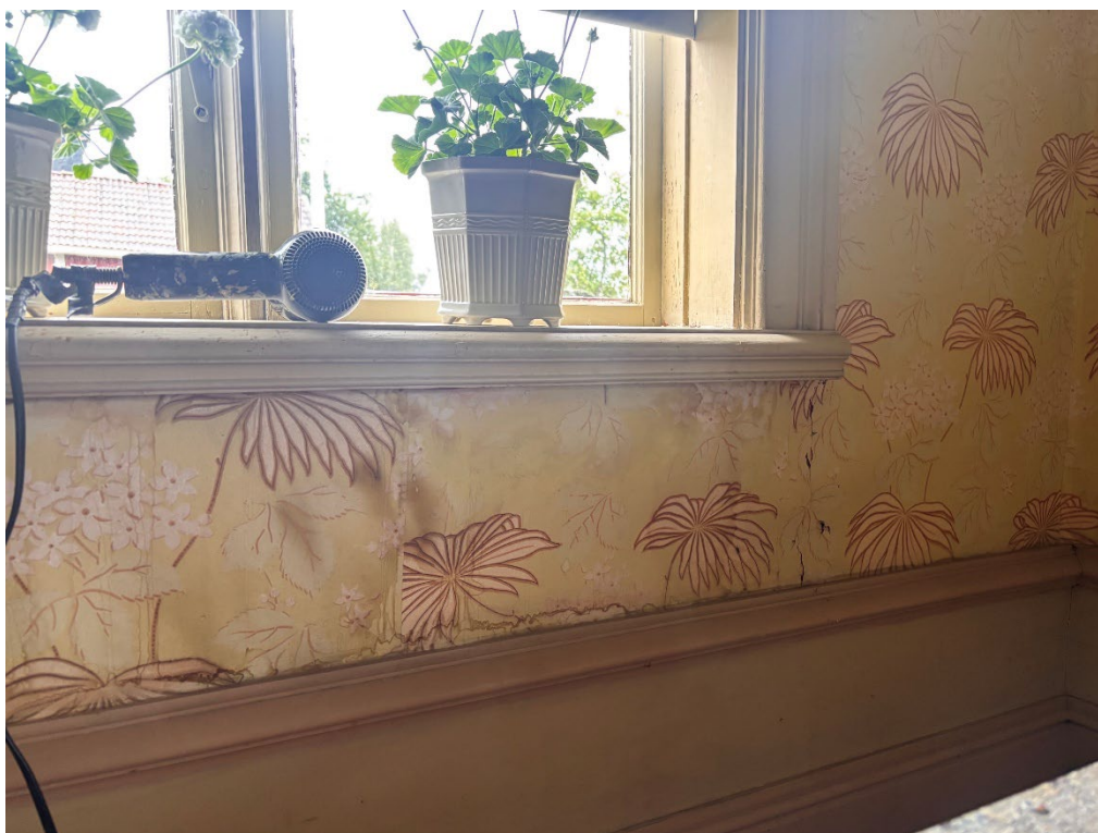
Figur 12. Under pågående arbeten med retuschering av fuktros under det högra fönstret som vetter ut mot trädgården. Foto: Ulrika Olsson, 2026-07-22.
