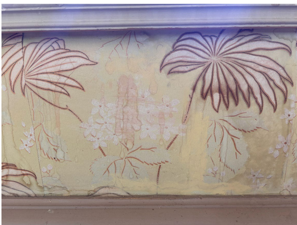
Figur 13. Efter avslutade arbeten med retuschering av fuktros under ett av fönstren. Foto: Ulrika Olsson, 2026-08-28.
