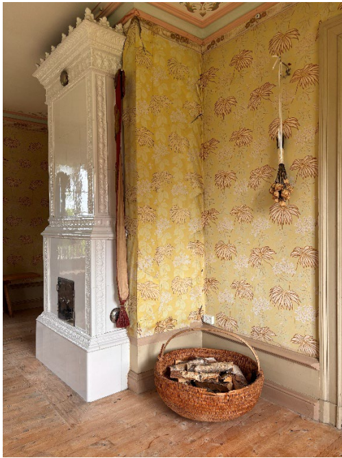
Figur 2 och 3. Skadorna i tapeten var störst vid murarna på vardera sidan om kakelugnen. tapeten hade dragit sig, spruckit sönder och släppt från underlaget. Foto: Ulrika Olsson, 2026-07-02.
