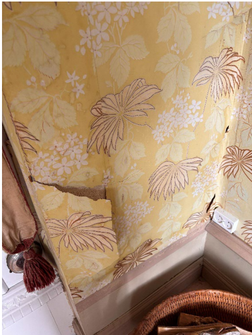
Figur 4 och 5. Närbild på skadorna i tapeten på muren på högra sidan om kakelugnen. Notera hur den bakomliggande putsen har påverkat kulörerna i trycket som är betydligt ljusare här än i övriga ytor. Foto: Ulrika Olsson, 2026-07-02.
