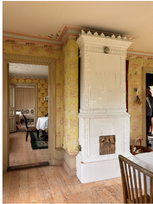
Figur 2 och 3. Skadorna i tapeten var störst vid murarna på vardera sidan om kakelugnen. tapeten hade dragit sig, spruckit sönder och släppt från underlaget. Foto: Ulrika Olsson, 2026-07-02.
