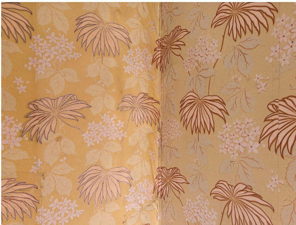
Figur 11. Närbild på hörnet till böger om kakelugnen efter att tapeten sträckts ut och limmats mot underlaget. Foto: Ulrika Olsson, 2026-08-28.
