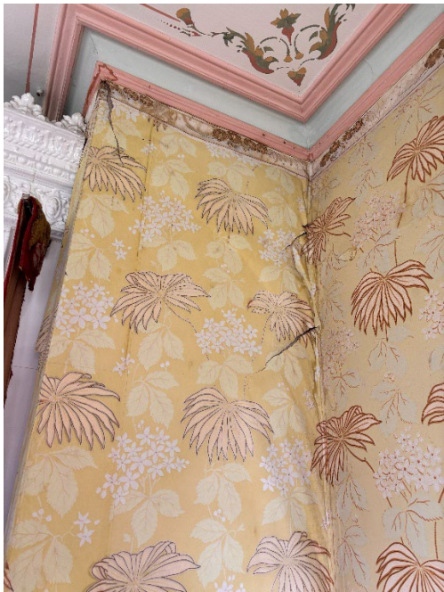
Figur 4 och 5. Närbild på skadorna i tapeten på muren på högra sidan om kakelugnen. Notera hur den bakomliggande putsen har påverkat kulörerna i trycket som är betydligt ljusare här än i övriga ytor. Foto: Ulrika Olsson, 2026-07-02.
