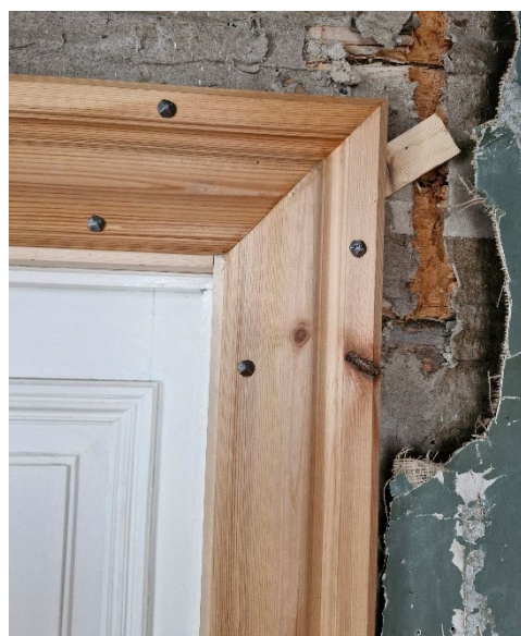
Figur 55. Detalj av monterat dörrfoder. Foto: Daniel Olsson, 2025-11-20.
