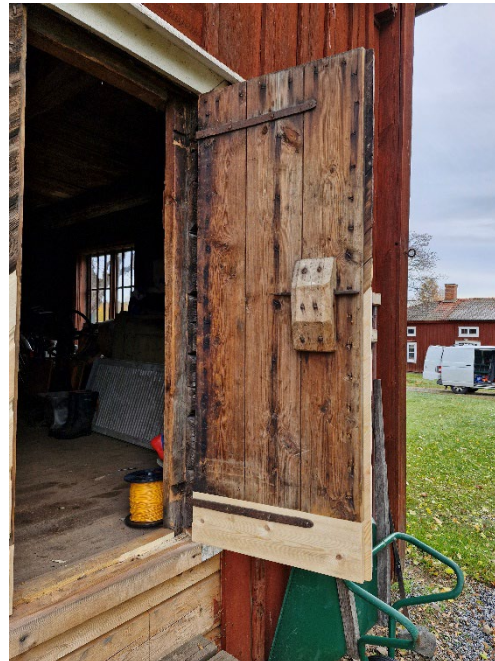
Figur 46. Detalj av insidan av det östra dörrbladet i den östra porten. Foto från sydväst: Daniel Olsson, 2025-10-07.
