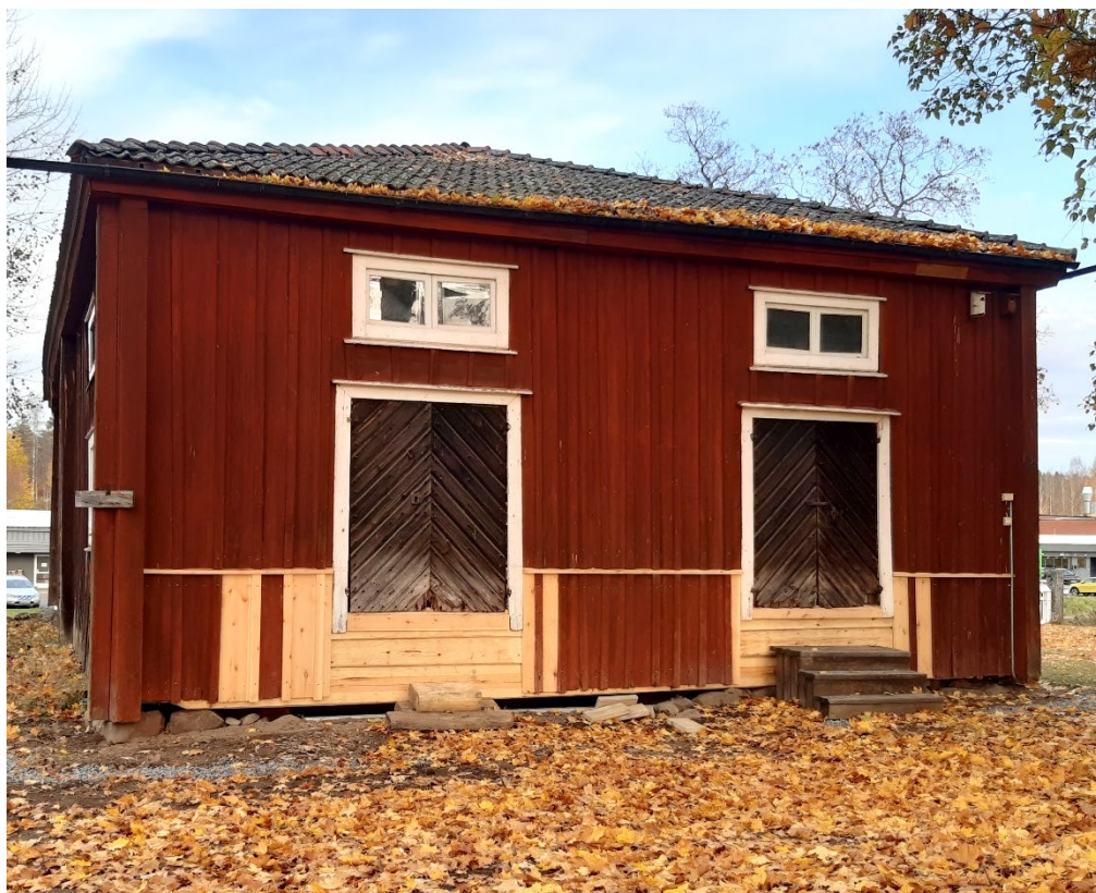
Figur 44. Den västra flygelbyggnadens södra fasad. Foto från söder: Daniel Olsson, 2024-10-18.
