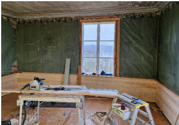
Figur 35. Arbetsbild från uppsättningen av bröstpanelen. Foto från sydöst: Daniel Olsson, 2025-11-07.
