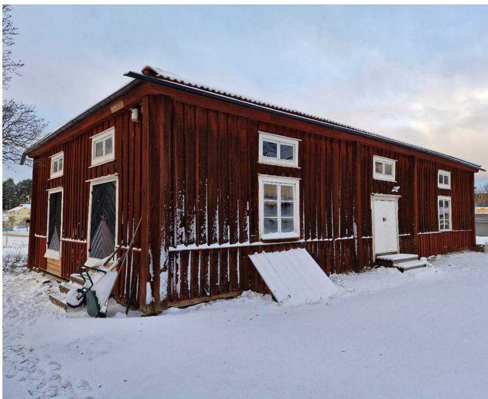
Figur 49. Den västra flygelbyggnaden från sydöst efter avslutad renovering. Foto: Daniel Olsson, 2025-11-20.
