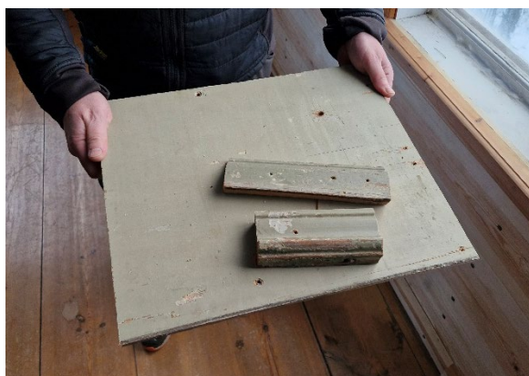
Figur 52. Sparade delar av den ursprungliga bröstpanelen, midjelist och golvsockel. Foto: Daniel Olsson, 2025-11-20.
