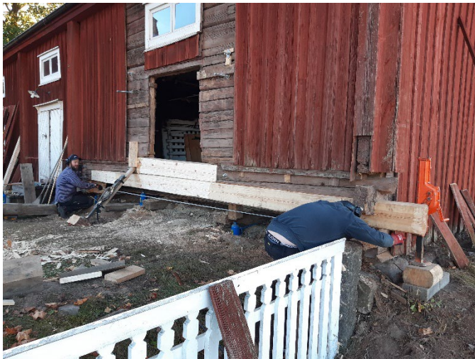
Figur 40. Detalj av timmerarbetet under den norra delen av den västra flygelbyggnadens östra fasad. Foto från nordöst: Daniel Olsson, 2024-09-26.
