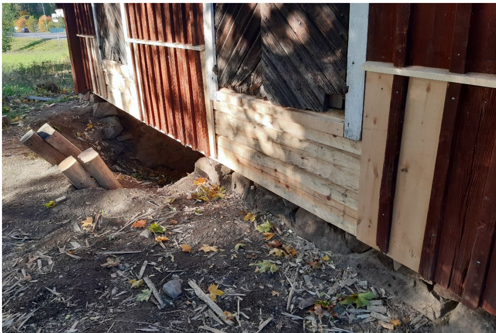
Figur 42. Utbytta stockar i den västra flygelbyggnadens södra fasad. Foto från sydöst: Daniel Olsson, 2024-09-26.
