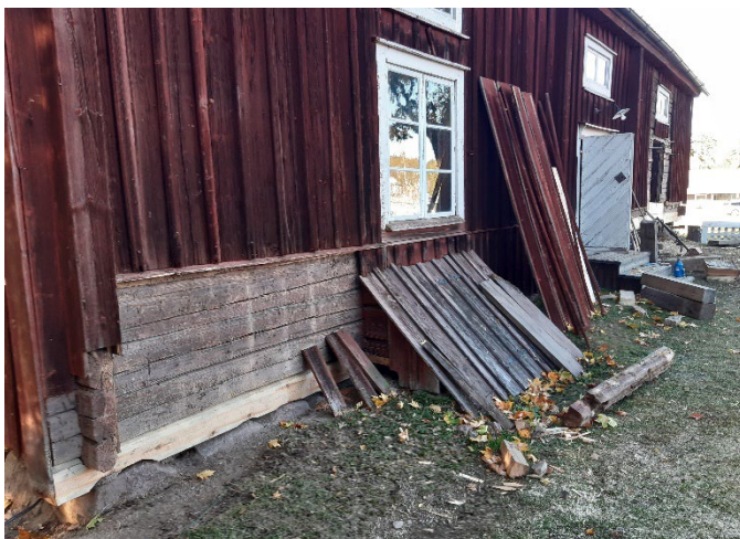
Figur 41. Detalj av utbytt syllstock i den södra delen av husets östra fasad. Foto från sydöst: Daniel Olsson, 2024-09-26.
