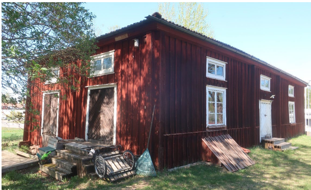
Figur 51. Den västra flygelbyggnaden från sydöst innan renoveringen inleddes. Foto: Daniel Olsson, 2024-05-16.
