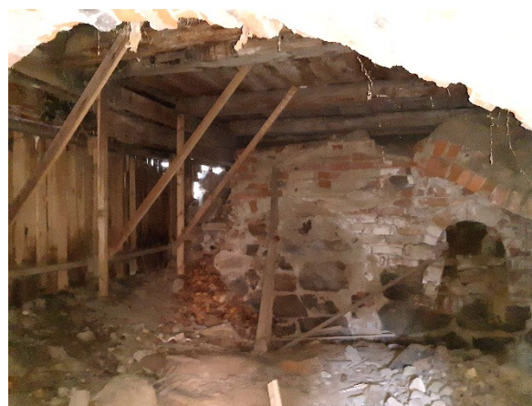
Figur 19. Detalj av den raserade valvslagna källaren samt panelväggen mot söder. Foto från nordöst: Daniel Olsson, 2023-06-15.
