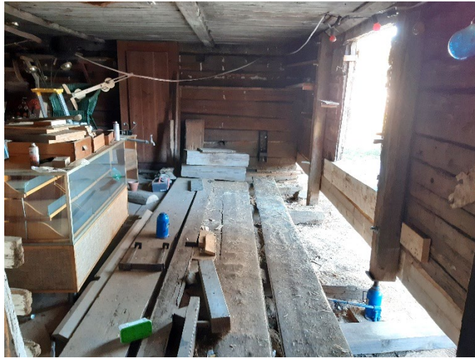
Figur 39. Detalj av det norra rummet efter demontering av delar av golvkonstruktionen. Foto från söder: Daniel Olsson, 2024-09-26.
