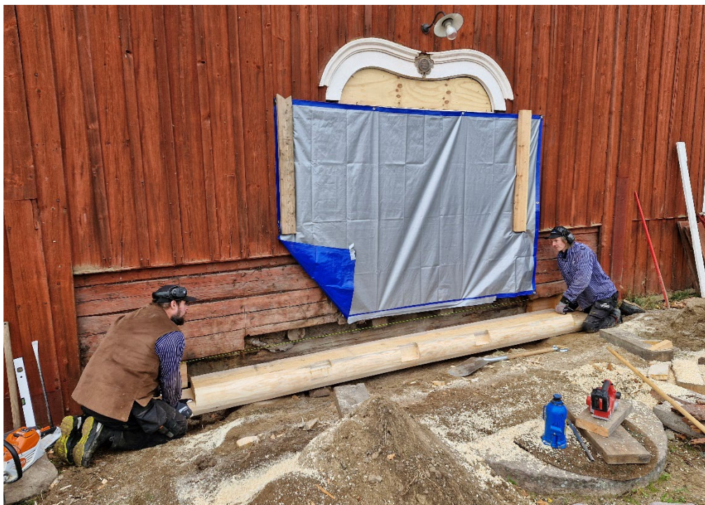
Figur 29. Lassas Byggnadsvård under arbetet med inpassningen av den nya syllstocken. Foto från nordöst: Daniel Olsson, 2025-10-17.
