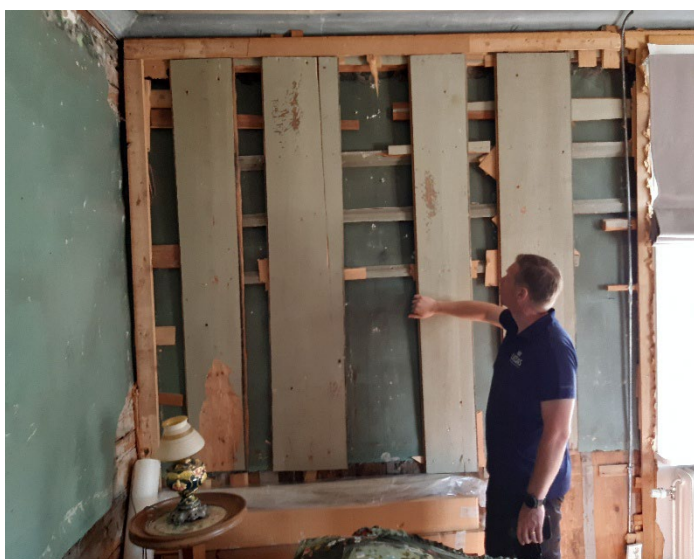
Figur 32. Martin Karlsson, Lassas Byggnadsvård, granskar de kvarvarande delarna av den tidigare panelen innan restaureringen inleddes. Foto från väster: Daniel Olsson, 2023-06-15.
