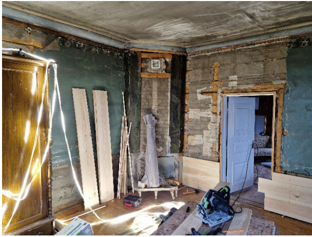
Figur 33. Arbetsbild från uppsättningen av bröstpanelen. Foto från sydöst: Daniel Olsson, 2025-11-07.
