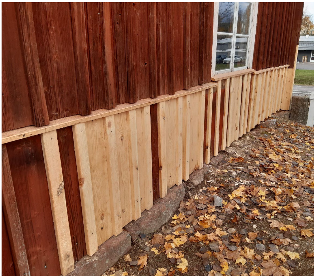
Figur 43. Detalj av fasadpanelen på den norra delen av den västra flygelbyggnadens östra fasad. Foto från sydöst: Daniel Olsson, 2024-10-18.
