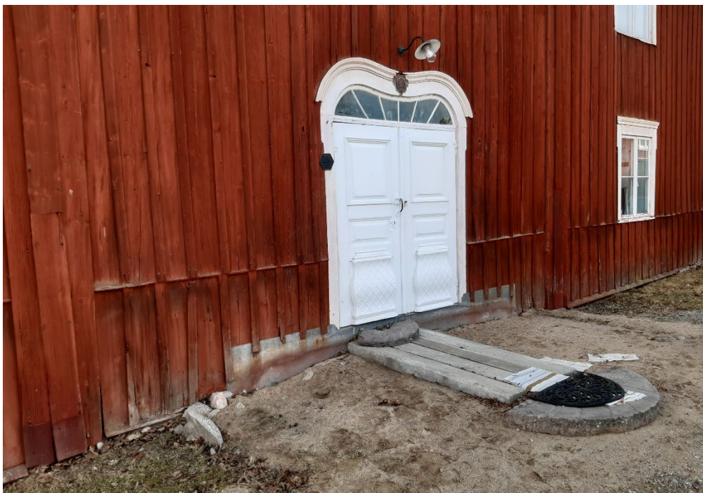
Figur 16. Detalj av huvudbyggnadens panel innan renoveringen. Foto från nordöst: Daniel Olsson, 2025-04-02.
