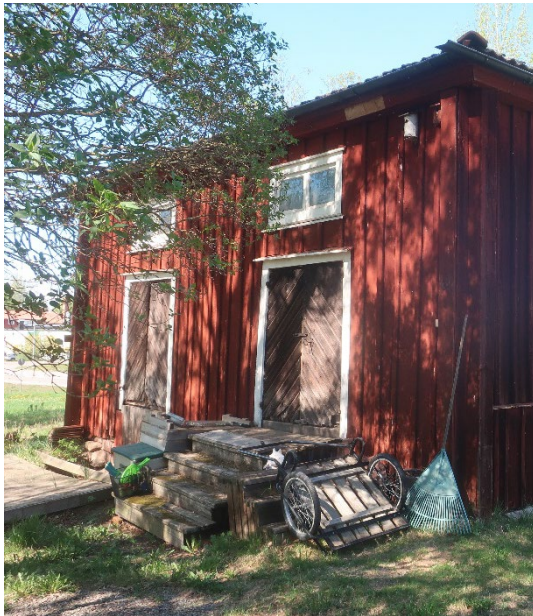
Figur 22. Portarna mot söder innan renoveringen. Foto från sydöst: Daniel Olsson, 2024-05-16.
