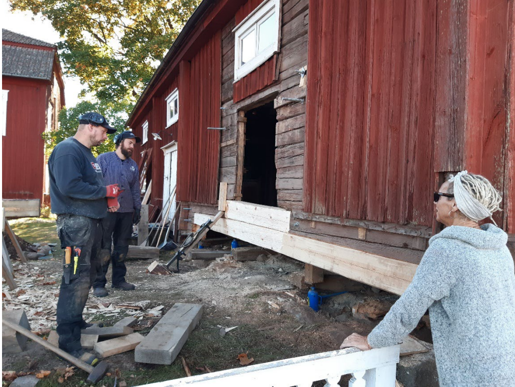
Figur 37. Besiktning av det pågående arbetet med den västra flygelbyggnadens östra fasad. Foto från nordöst: Daniel Olsson, 2024-09-26.
