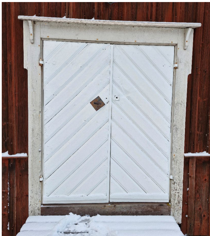
Figur 48. Den västra flygelbyggnadens port mot öster efter ommålning. Foto från öster: Daniel Olsson, 2025-11-20.
