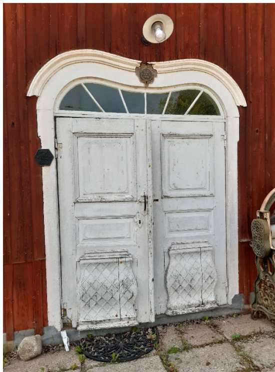
Figur 13. Huvudbyggnadens pardörr från norr innan renoveringen. Foto: Daniel Olsson, 2023-06-15.
