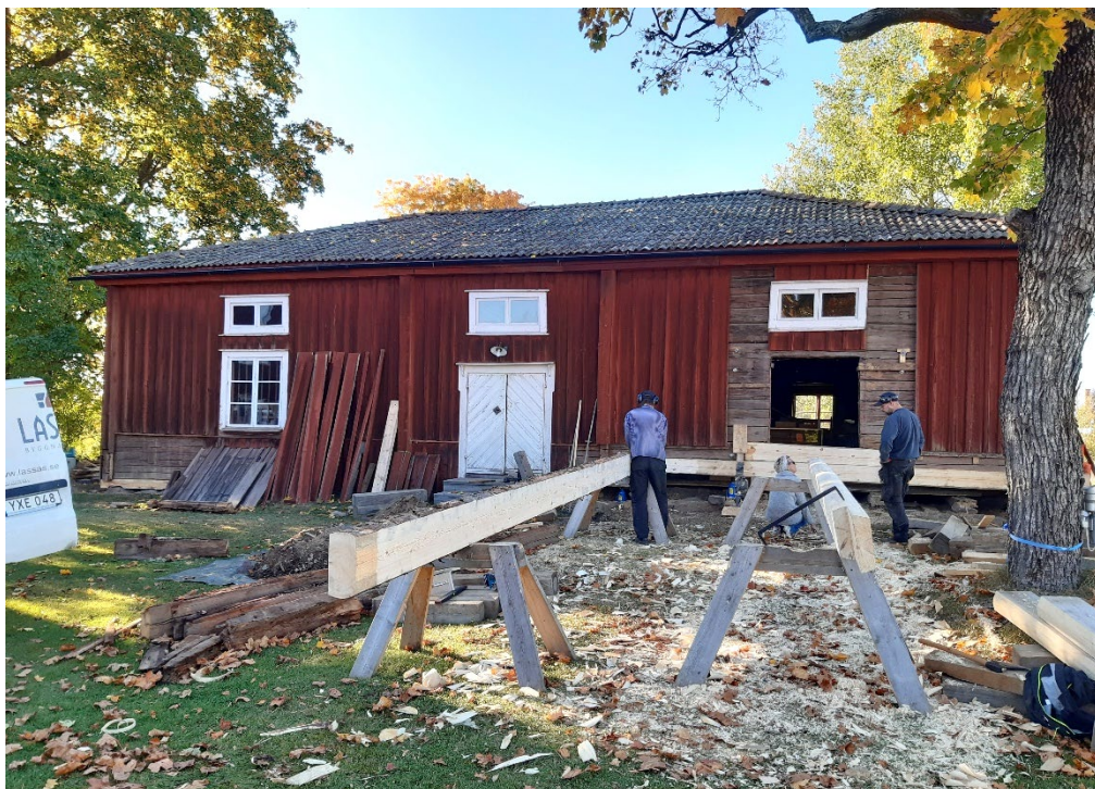
Figur 24. Lassas Byggnadsvård arbetar med timmer till den västra flygelbyggnaden. Foto från öster: Daniel Olsson, 2024-09-26.
