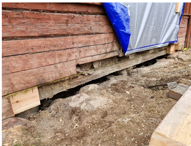
Figur 28. Detalj av stommen kring huvudentrén efter borttagande av de rötskadade delarna av stockarna. Foto från nordöst: Daniel Olsson, 2025-10-17.
