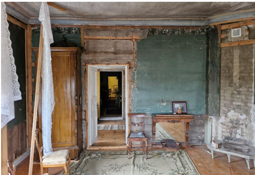
Figur 31. Det sydöstra hörnrummet från öster innan restaureringen inleddes. Foto: Daniel Olsson, 2025-09-03.
