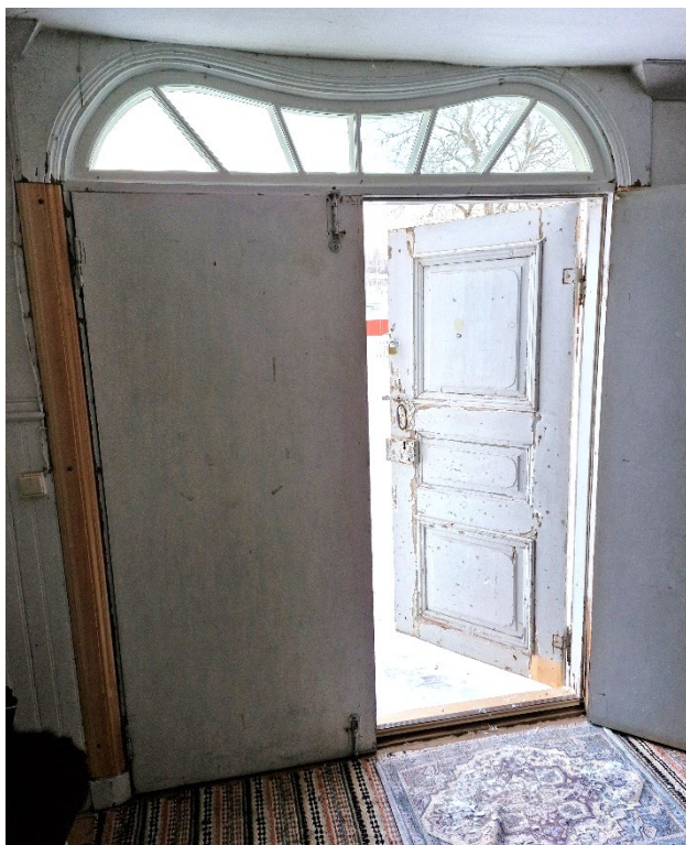
Figur 27. Dörren inifrån med nytillverkat innanfönster och nyuppsatta dörrfoder (det västra syns på bilden). Foto från sydväst: Daniel Olsson, 2025-11-20.
