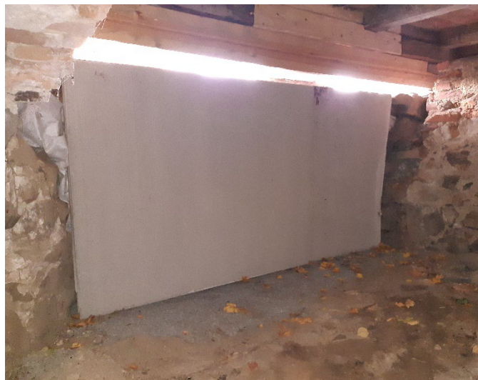
Figur 38. Detalj av de nya betongstöden inifrån källaren. Foto från nordöst: Daniel Olsson, 2024-10-18.
